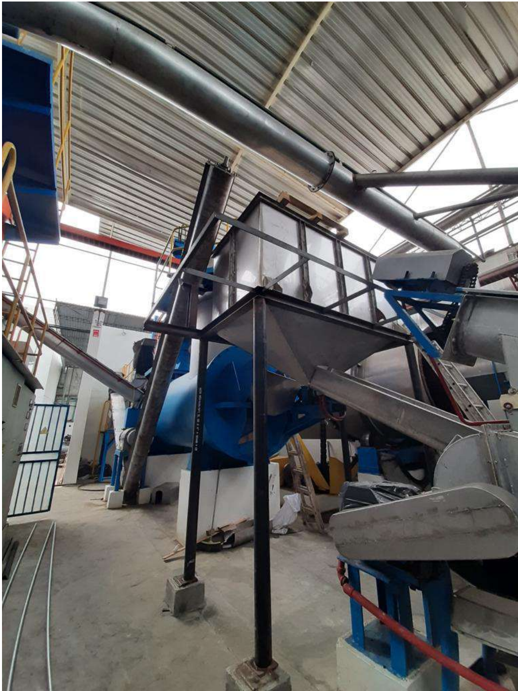
Figura 7. Tolva recirculadora de scrap, montaje concluido.
