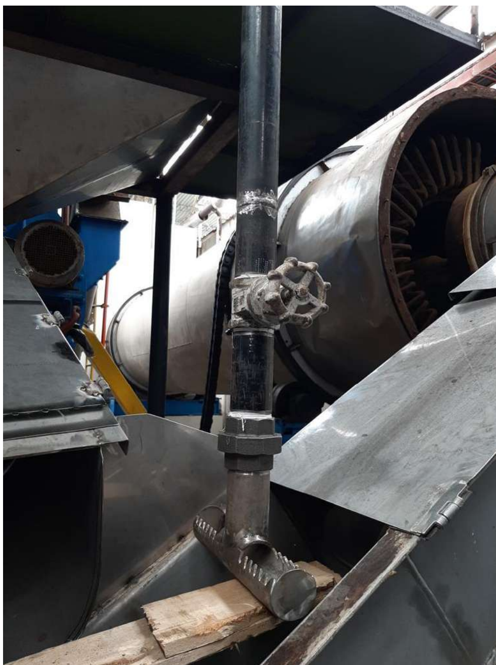
Figura 4. Punto dosificación de concentrado, tolva recirculadora de scrap
