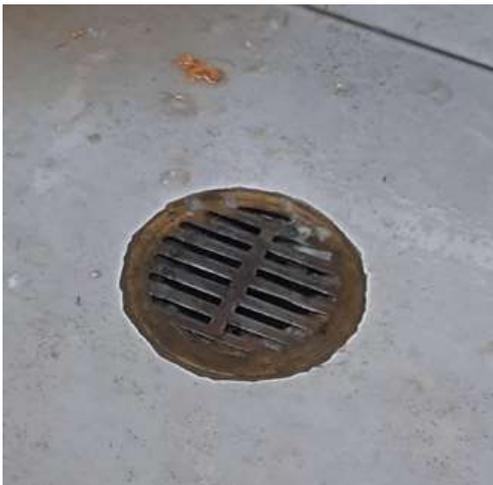
Imagen 14.- Rejilla de Drenaje del Desagüe de Cada Puesto
