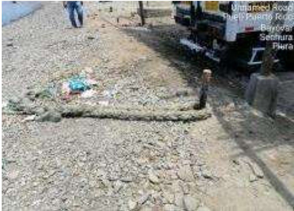
Figura 24. Plataforma de Pedro Plataforma Puerto Rico 22 Morán Valladolid, en mal estado de conservación.
