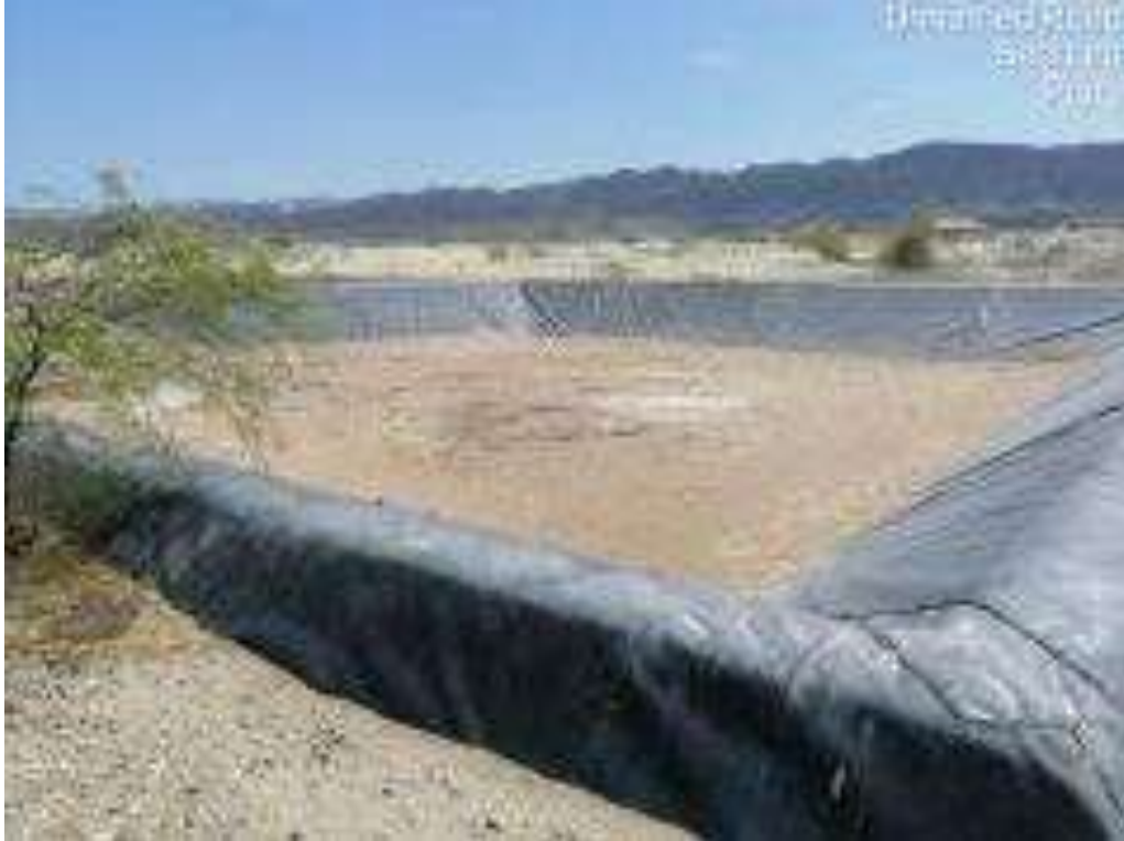
Figura 28. Planta Piloto de tratamiento de mineral - Misky Mayo. Zona de viviendas, se evidencia infraestructura de planta piloto de tratamiento de mineral.
