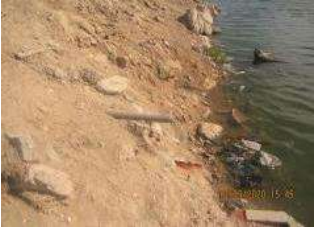
Figura 32. Parachique, se evidencia tubería de PVC de 2", con salida al mar.
