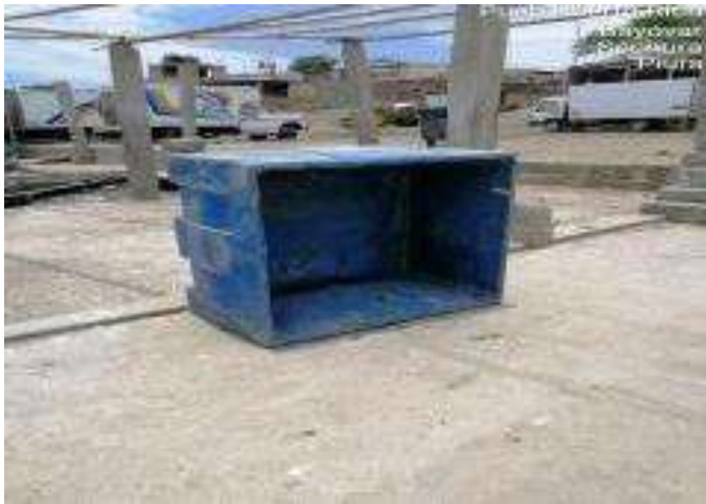
Figura 21. Plataforma Puerto Rico 4 sin toldo, con presencia de heces, cajón inoperativo.
