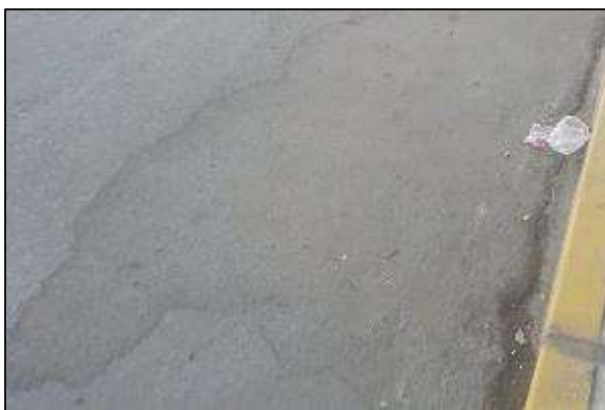
Fotografía 5: Identificación de fallas tipo Bache.
