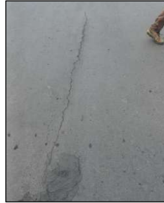
Fotografía 1: Identificación de grieta longitudinal.
