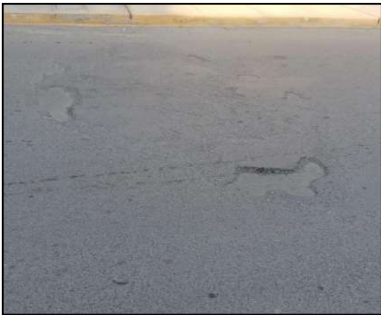
Fotografía 4: Identificación de fallas tipo piel de cocodrilo.
