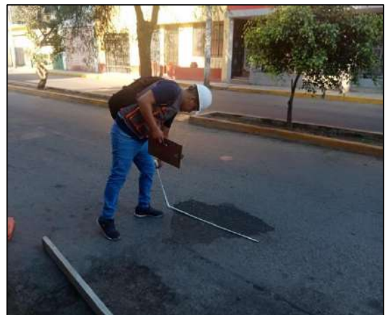
Fotografía 5: Identificación de fallas tipo Bache.
