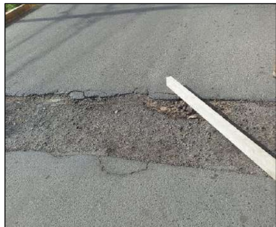
Fotografía 5: Identificación de fallas tipo Bache.
