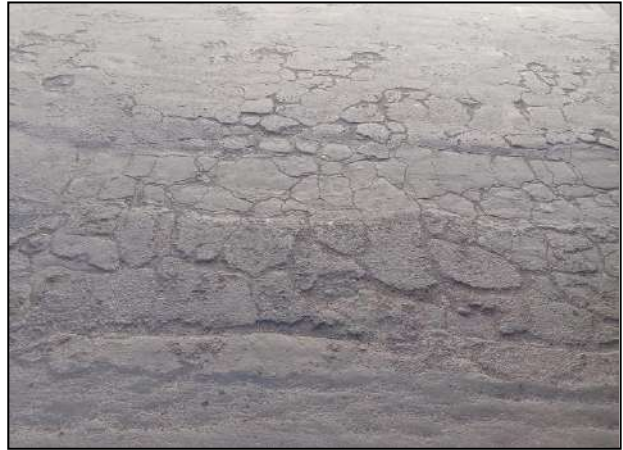
Fotografía 4: Identificación de fallas tipo piel de cocodrilo.
