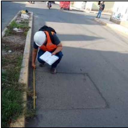
Fotografía 1: Identificación de grieta longitudinal.
