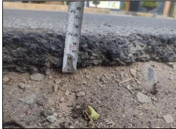
Fotografía 8: Espesor del pavimento en campo
