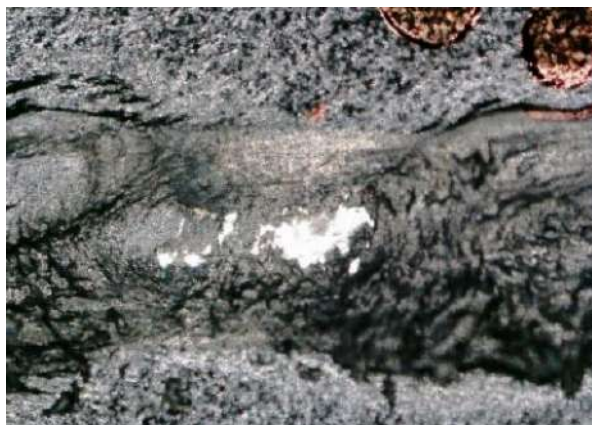
Figura 50: Panel con recubrimiento 2, penetración con una carga de 1N. Fuente: Elaboración propia.
