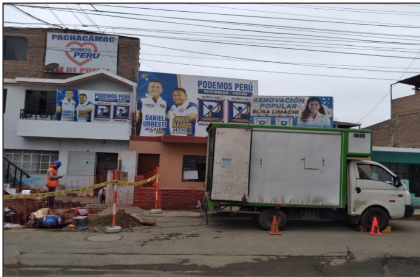
Figura 25. Excavación para tuberías de conexión
