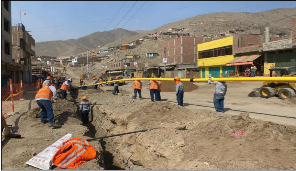
Figura 28. Tendido de tubería de Polietileno
