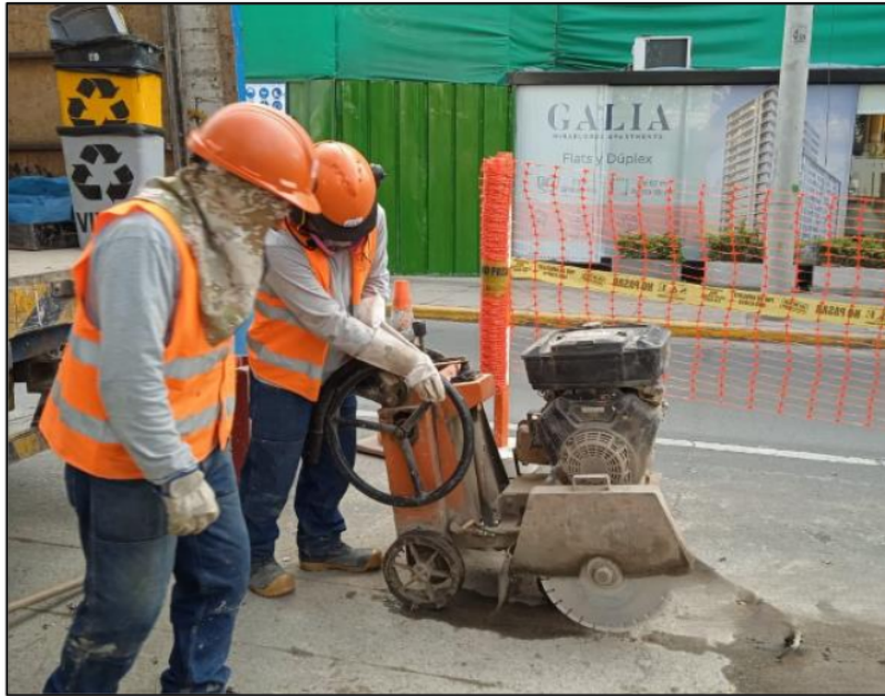
Figura 26. Corte de pavimento
