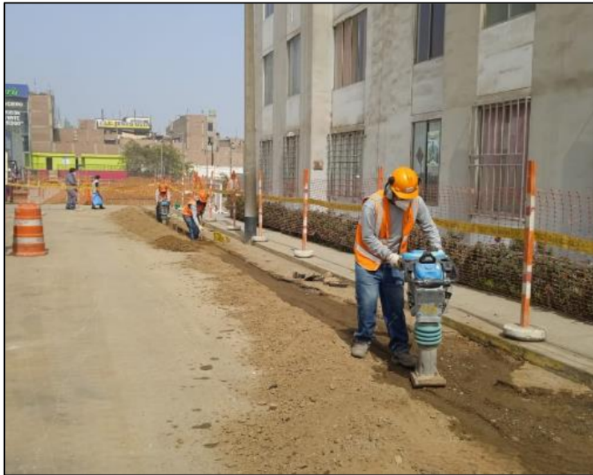
Figura 31. Relleno y compactación de zanja
