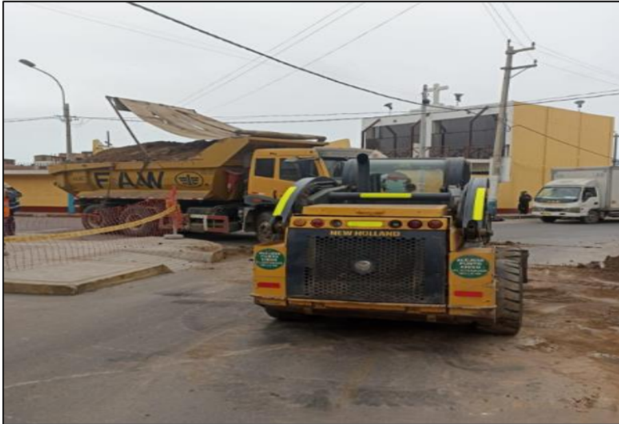
Figura 34. Reposición de pavimento y vereda
