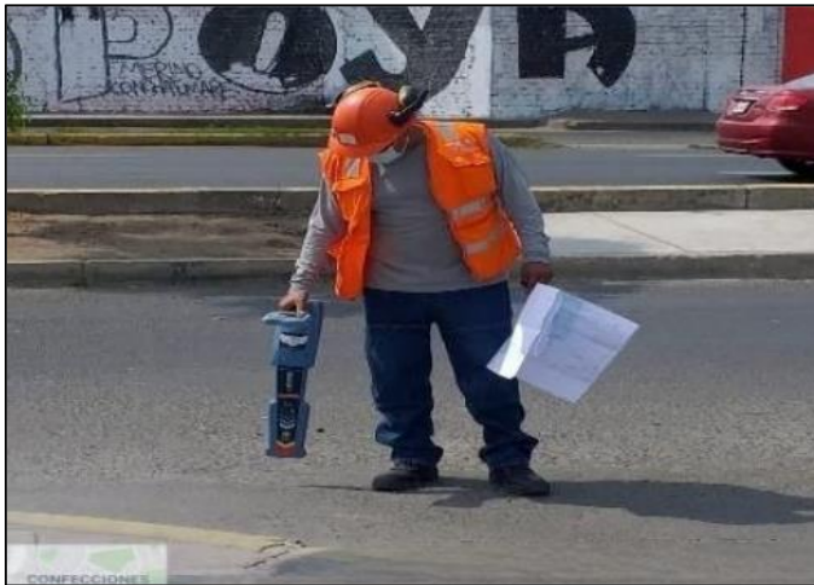
Figura 27. Detección de interferencias eléctricas.
