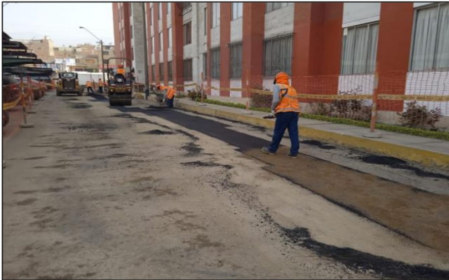
Figura 35. Eliminación de material excedente
