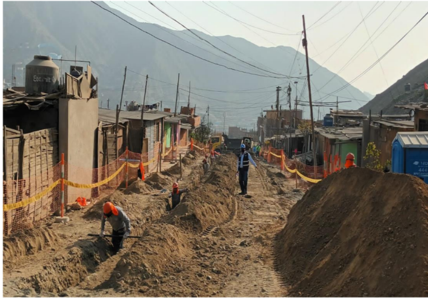
Figura 30. Excavación de zanja
