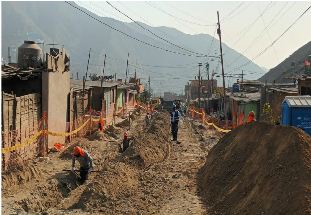
Figura 30. Excavación de zanja
