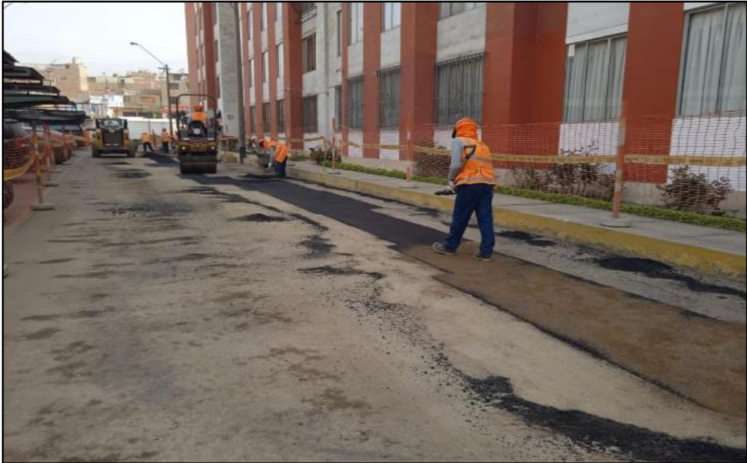
Figura 35. Eliminación de material excedente
