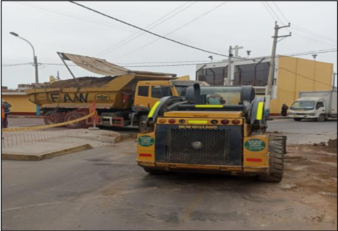
Figura 34. Reposición de pavimento y vereda
