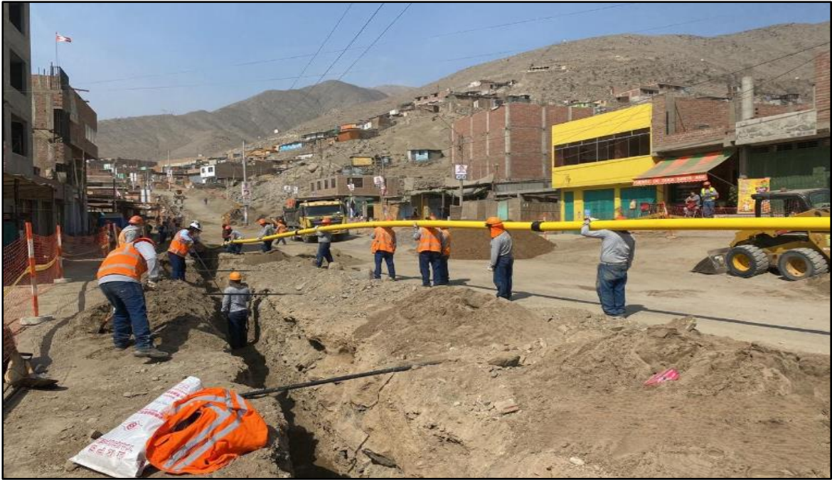
Figura 28. Tendido de tubería de Polietileno
