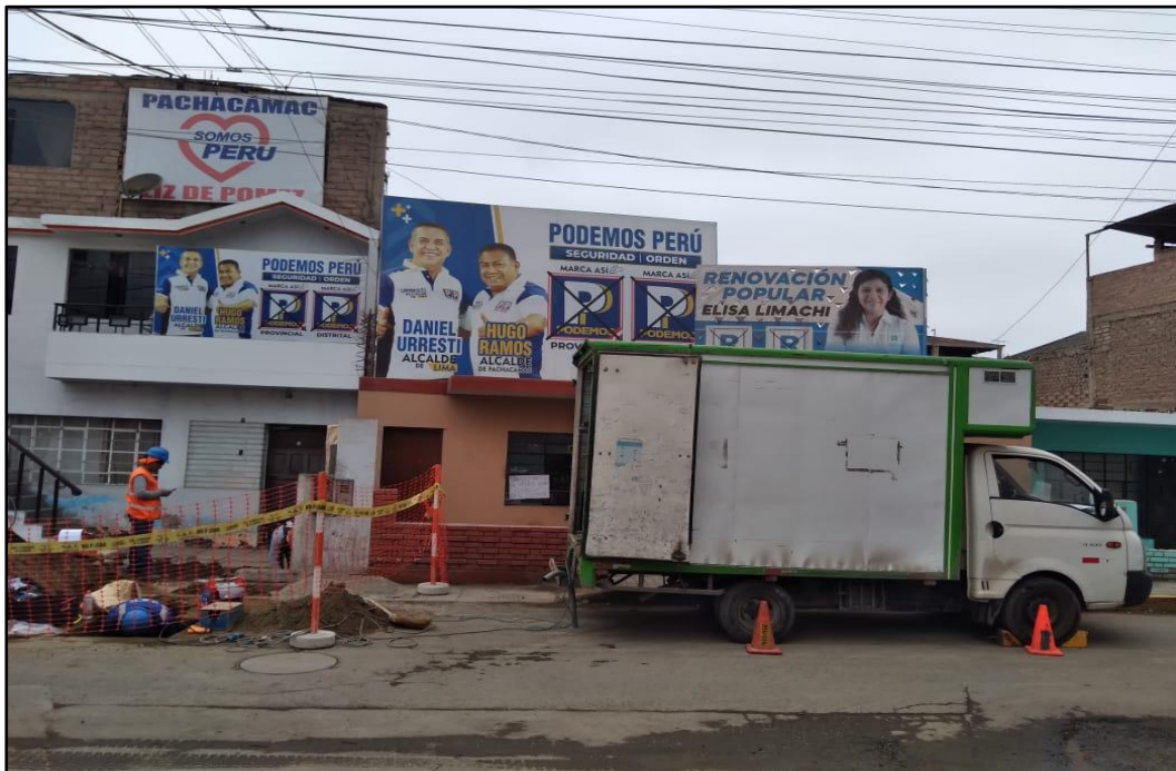
Figura 25. Excavación para tuberías de conexión
