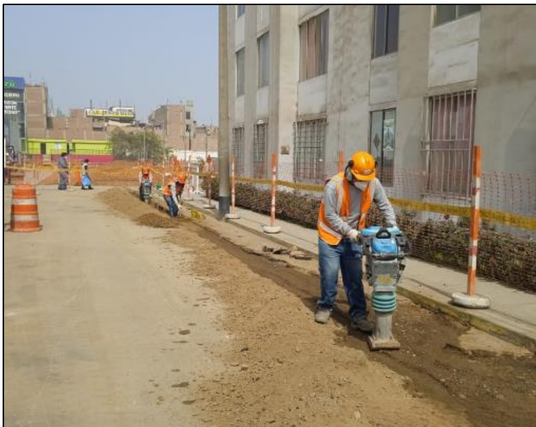
Figura 31. Relleno y compactación de zanja
