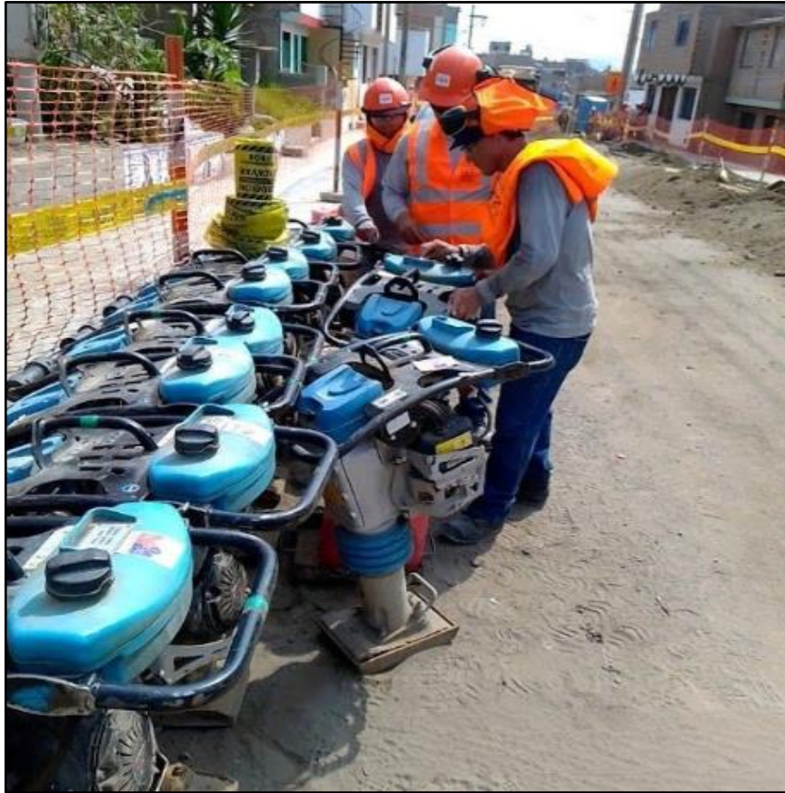
Figura 16. Vibroapisonador en obra
