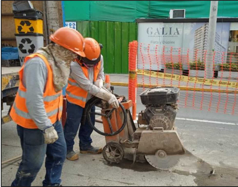
Figura 26. Corte de pavimento
