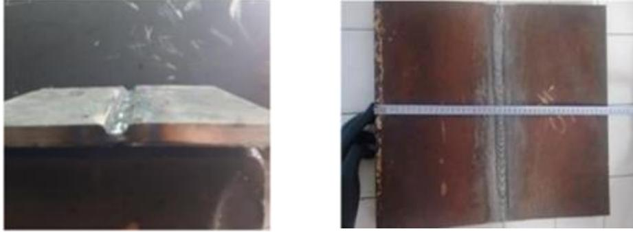
**Figura 8.** Realización del primer cordón de soldadura
