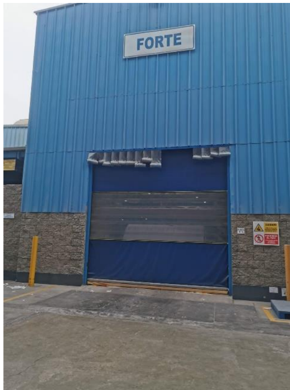
Figura 8: Puerta rápida enrollable en la planta Kimberly Clark sede Puente Piedra
