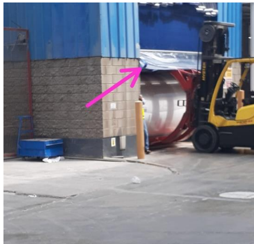
Figura 11: Puerta colisionando con unidades vehiculares, planta Kimberly Clark
