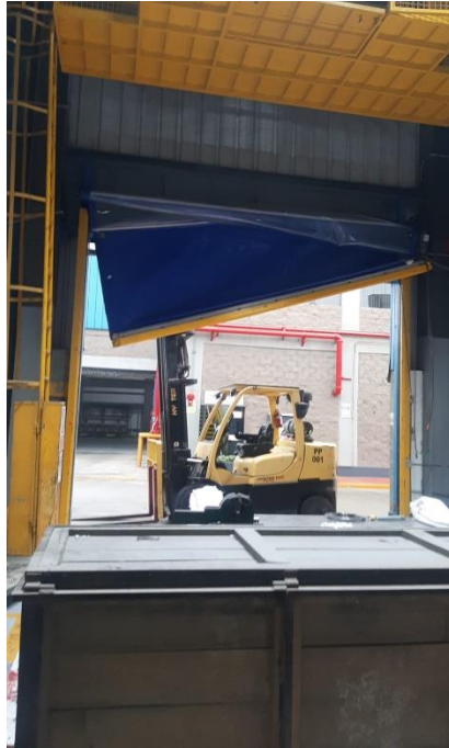
Figura 10: Puerta rápida elevándose solo parcialmente, planta Kimberly Clark sede
