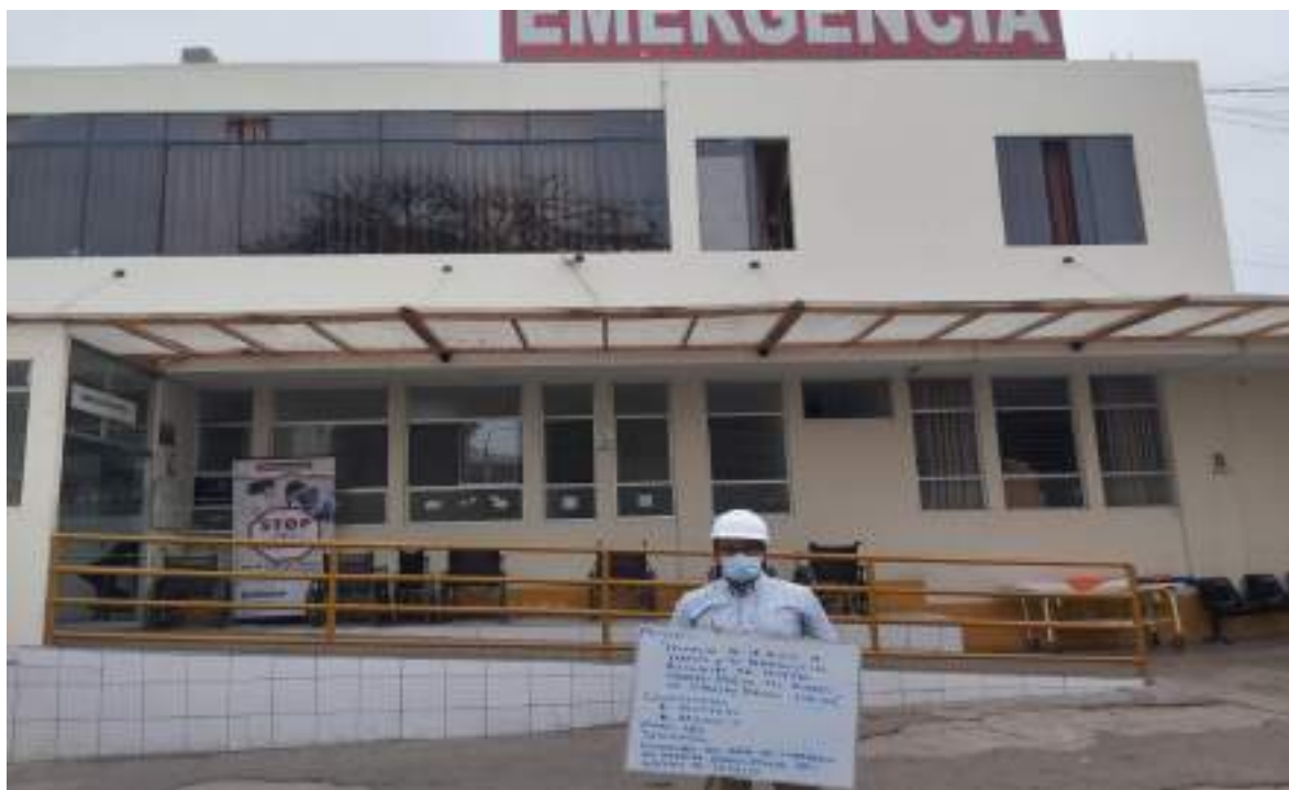
Figura 21 Exteriores del Área de Emergencia del Hospital Hidalgo Atoche del Distrito de Chancay
