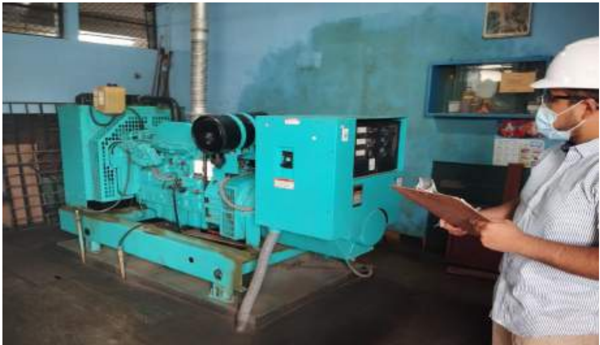
Figura 31 Emisión directa por consumo de Combustible -Generador
