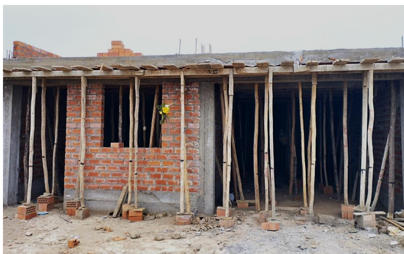
Figura 56 Foto panorámica de la vivienda N° 05
