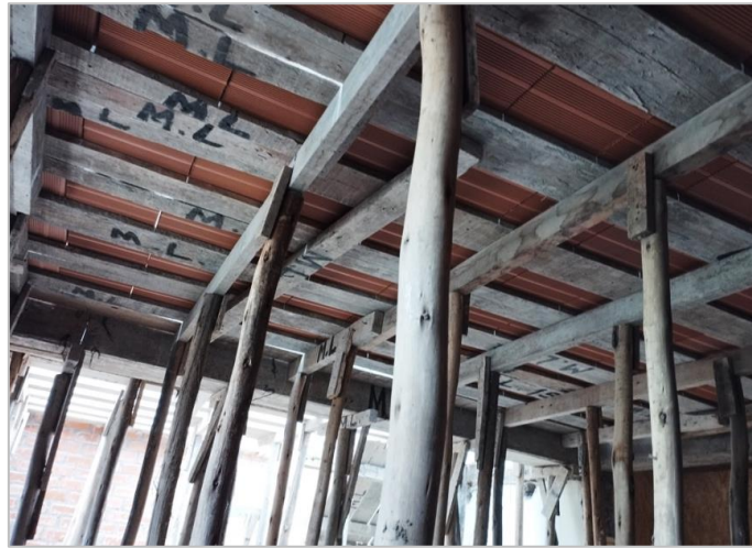
Figura 19 Pies derechos usados en el encofrado de la vivienda N° 01
