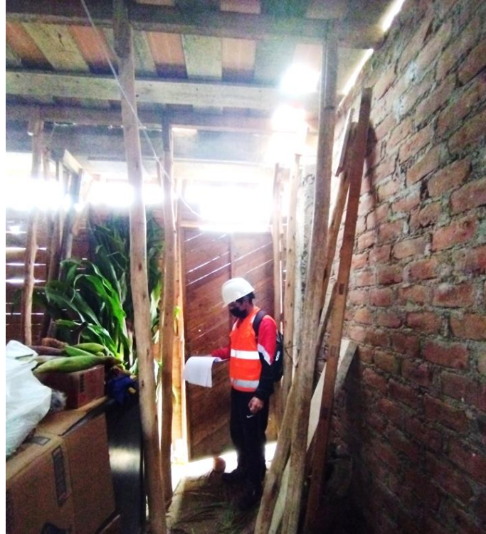
Figura 72 Separación de pies derechos en el encofrado de la vivienda N° 06
