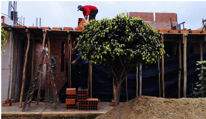
Figura 14 Foto panorámica de la vivienda N° 01
