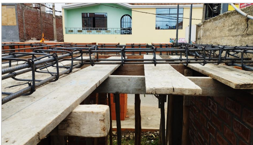
Figura 17 Soleras usadas en el encofrado de la vivienda N° 01
