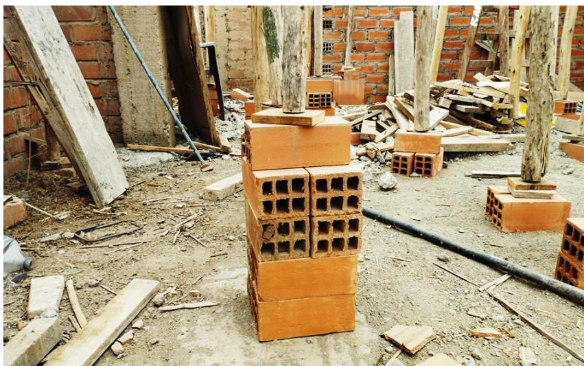
Figura 84 Cuña del pie derecho usada en el encofrado de la vivienda N° 07
