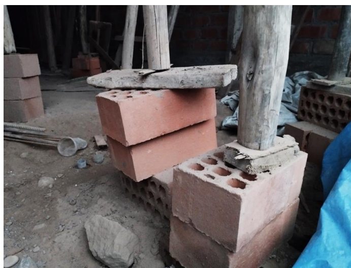
Figura 45 Cuñas usadas en los pies derechos del encofrado de la vivienda N° 03
