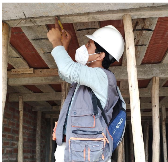
Figura 59 Medición de la solera en el encofrado de la vivienda N° 05
