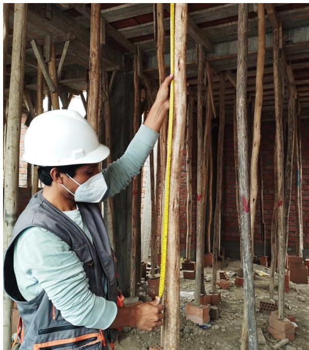
Figura 42 Medición de la altura de pies derechos en la vivienda N° 03
