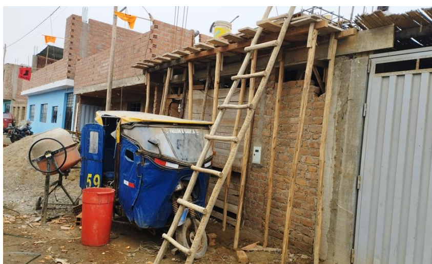
Figura 65 Foto panorámica de la vivienda N° 06
