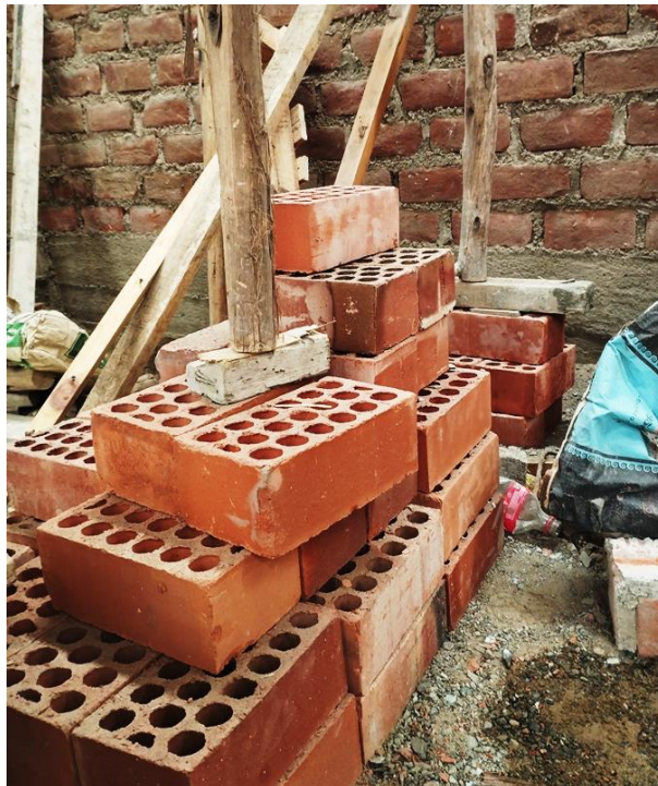
Figura 55 Cuña utilizada en el encofrado de la vivienda N° 04
