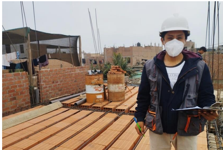
Figura 66 Distribución de unidades de albañilería alveolares en la vivienda N° 06
