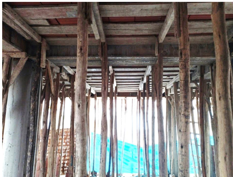
Figura 40 Pies derechos usados en el encofrado de la vivienda N° 03
