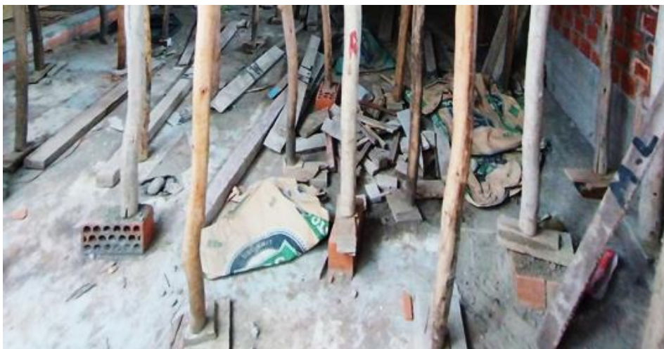
Figura 20 Cuñas usadas bajo los pies derechos en la vivienda N° 01
