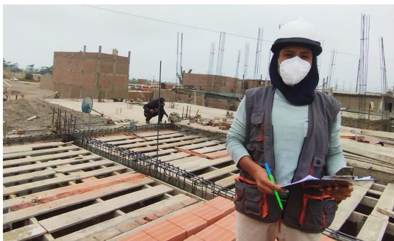
Figura 48 Toma de datos del encofrado en la vivienda N° 04
