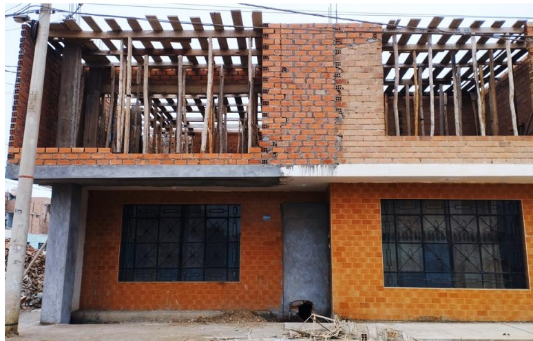
Figura 76 Foto panorámica de la vivienda N° 07
