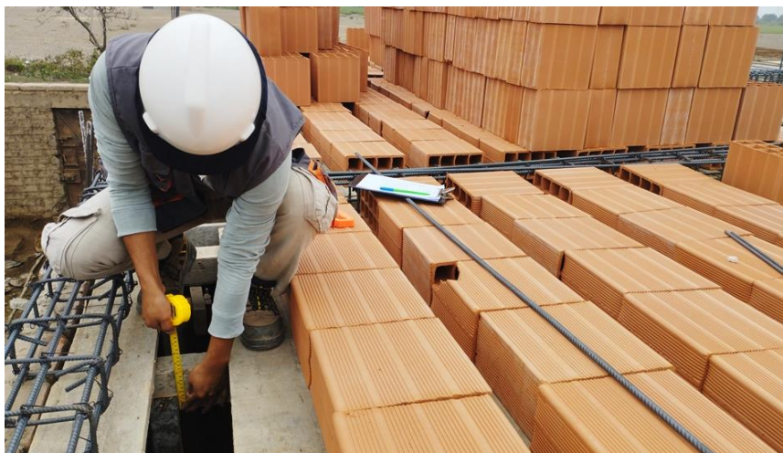
Figura 50 Medición de la altura de soleras en el encofrado de la vivienda N° 04
