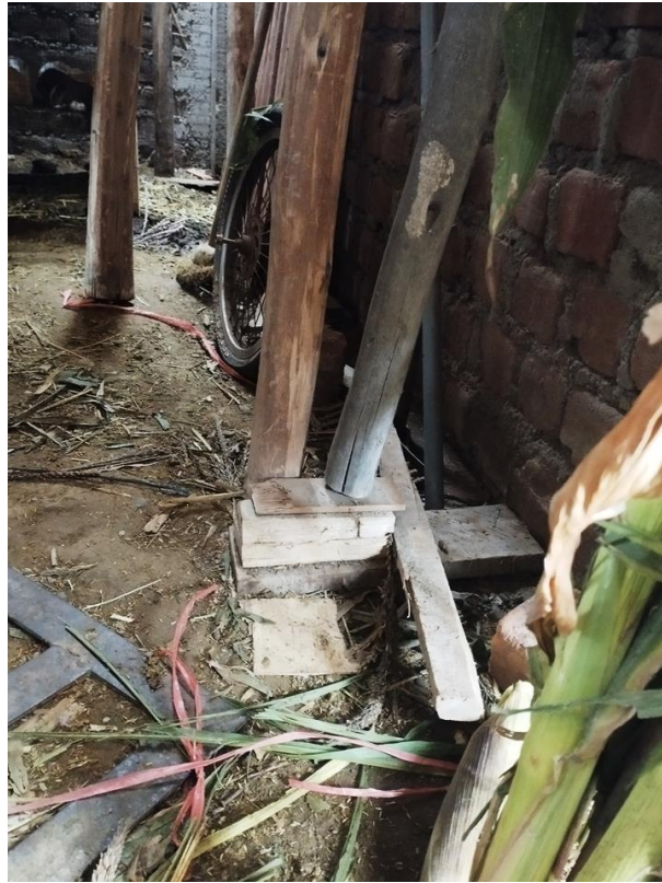
Figura 74 Cuñas de madera utilizadas en el encofrado de la vivienda N° 06
