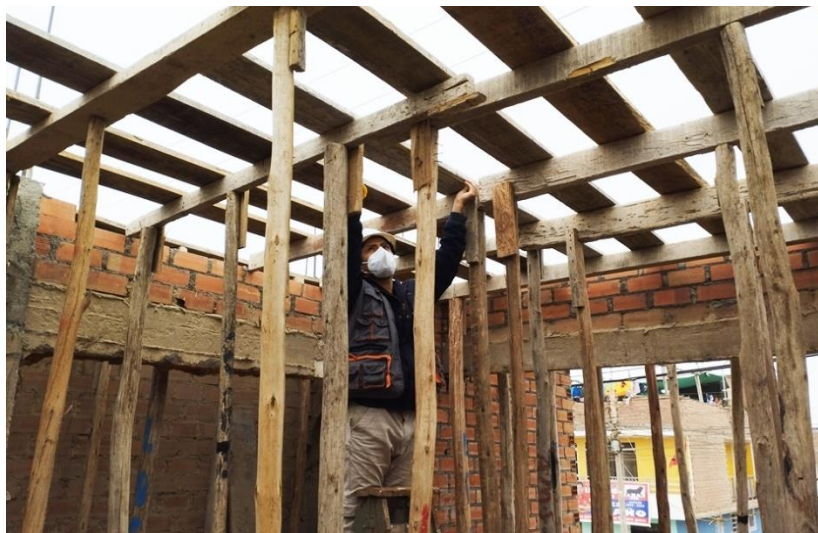
Figura 79 Medición de soleras en el encofrado de la vivienda N° 07
