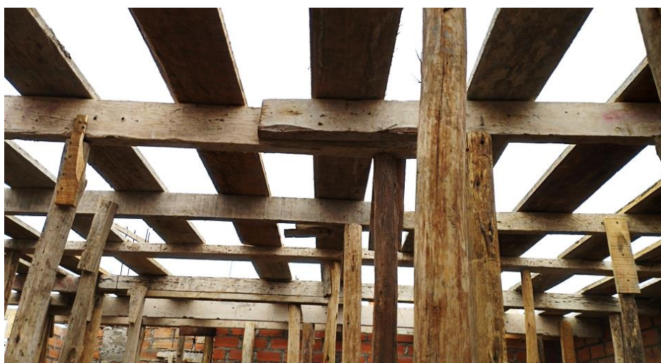
Figura 81 Soleras traslapadas usadas en el encofrado de la vivienda N° 07
