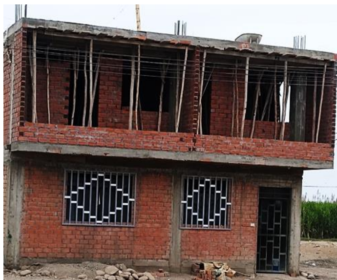
Figura 24 Foto panorámica de la vivienda N° 02
