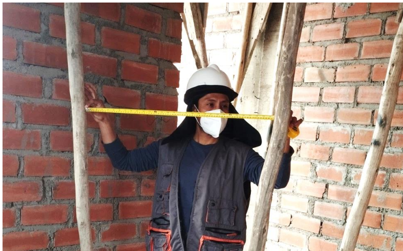
Figura 29 Medición de la separación entre pies de derechos en la vivienda N° 02
