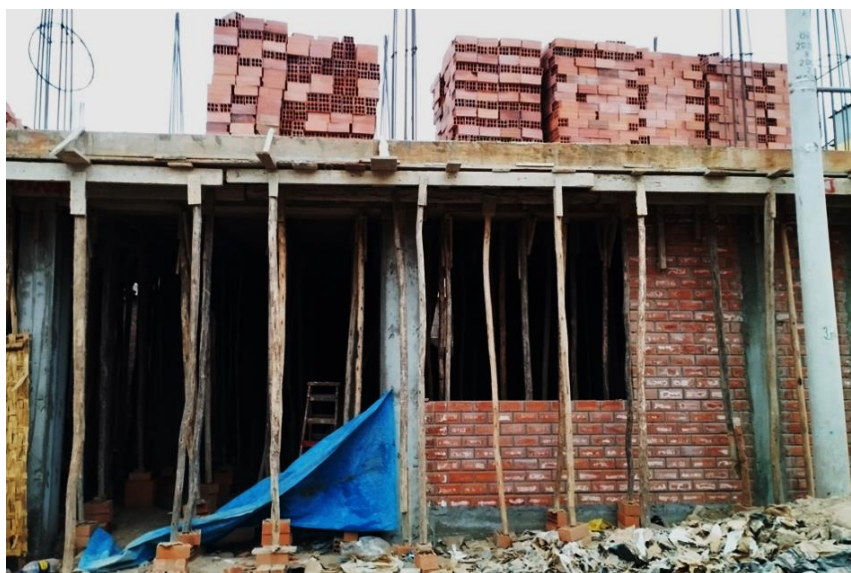
Figura 34 Foto panorámica de la vivienda N° 03
