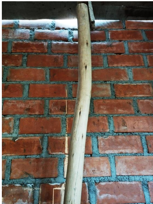
Figura 23 Pie derecho con curvatura notoria en la vivienda N° 01
