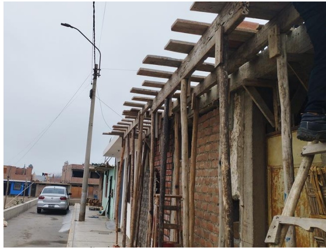
Figura 46 Foto panorámica de la vivienda N° 04
