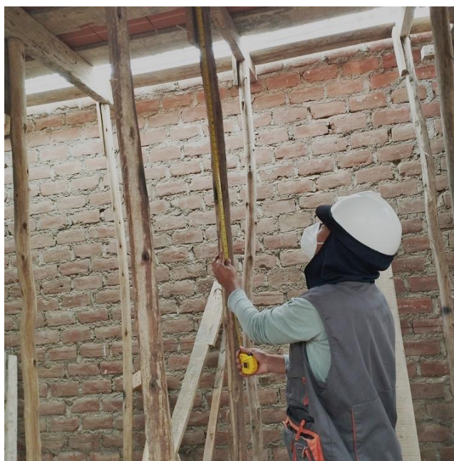
Figura 52 Medición de pies derechos en el encofrado de la vivienda N° 04
