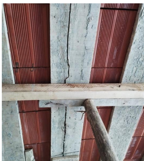
Figura 44 Tablón roto utilizado en el encofrado de la vivienda N° 03
