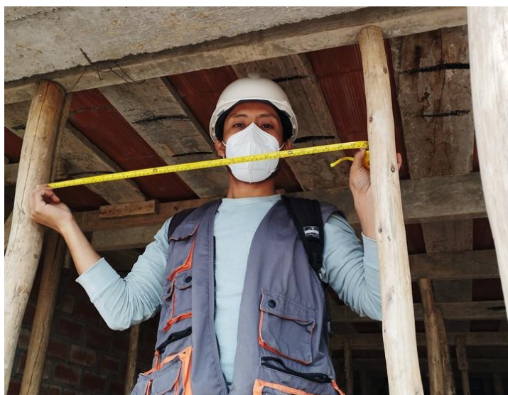
Figura 61 Medición de pies derechos en el encofrado de la vivienda N° 05
