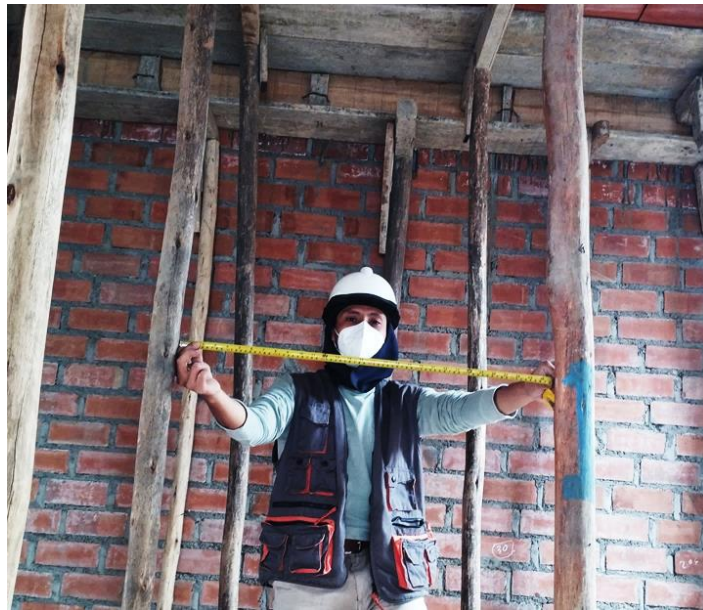
Figura 41 Medición de la separación entre pies derechos en la vivienda N° 03
