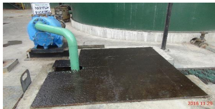
Figura N° : Pozo colector efluente de limpiez
