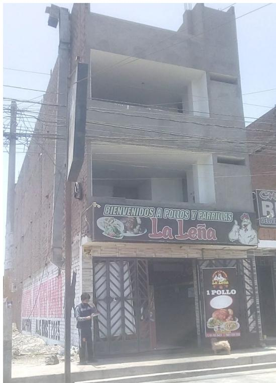
Figura 6. Edificación de 3 niveles, tipo de edificación de albañilería como material predominante, se destaca tener elementos parapetos. Fuente: Elaboración propia.
