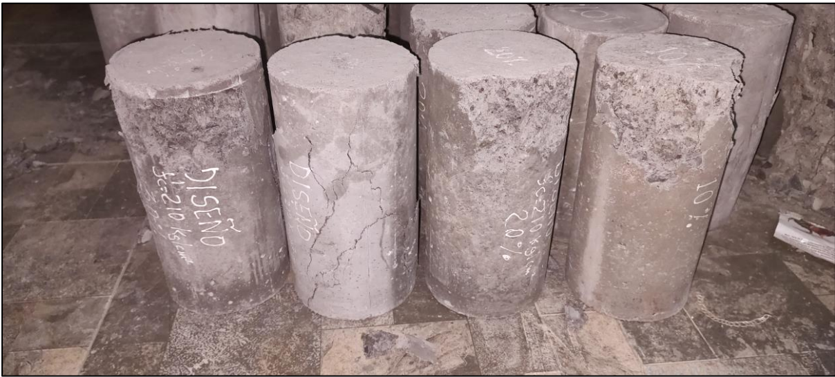
Figura N°21: Rotura de las probetas de concreto
