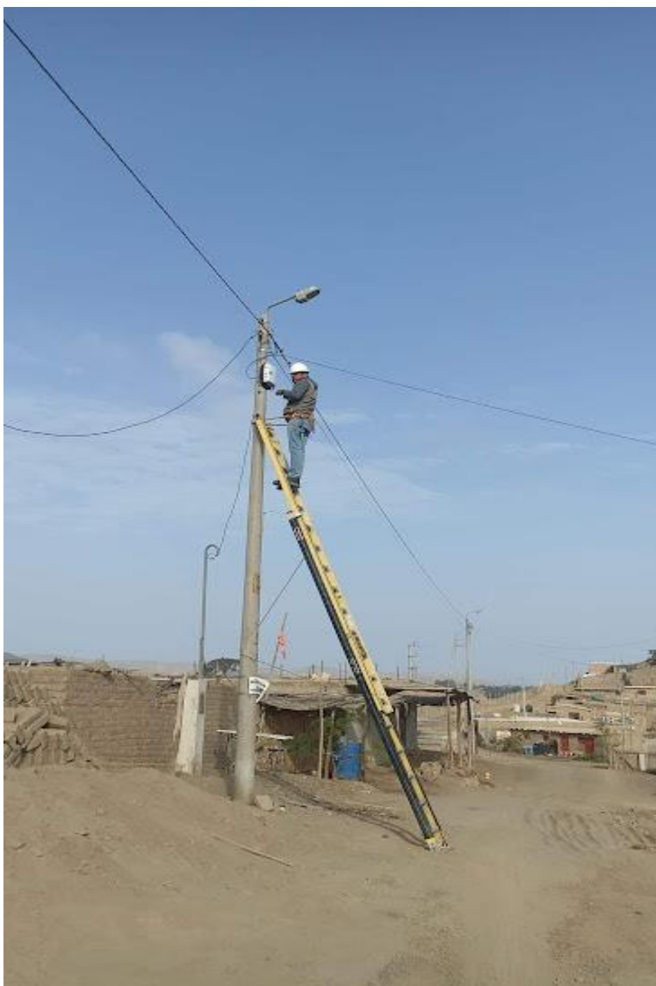
Imagen 3: Instalación y pruebas de las cajas FATS
