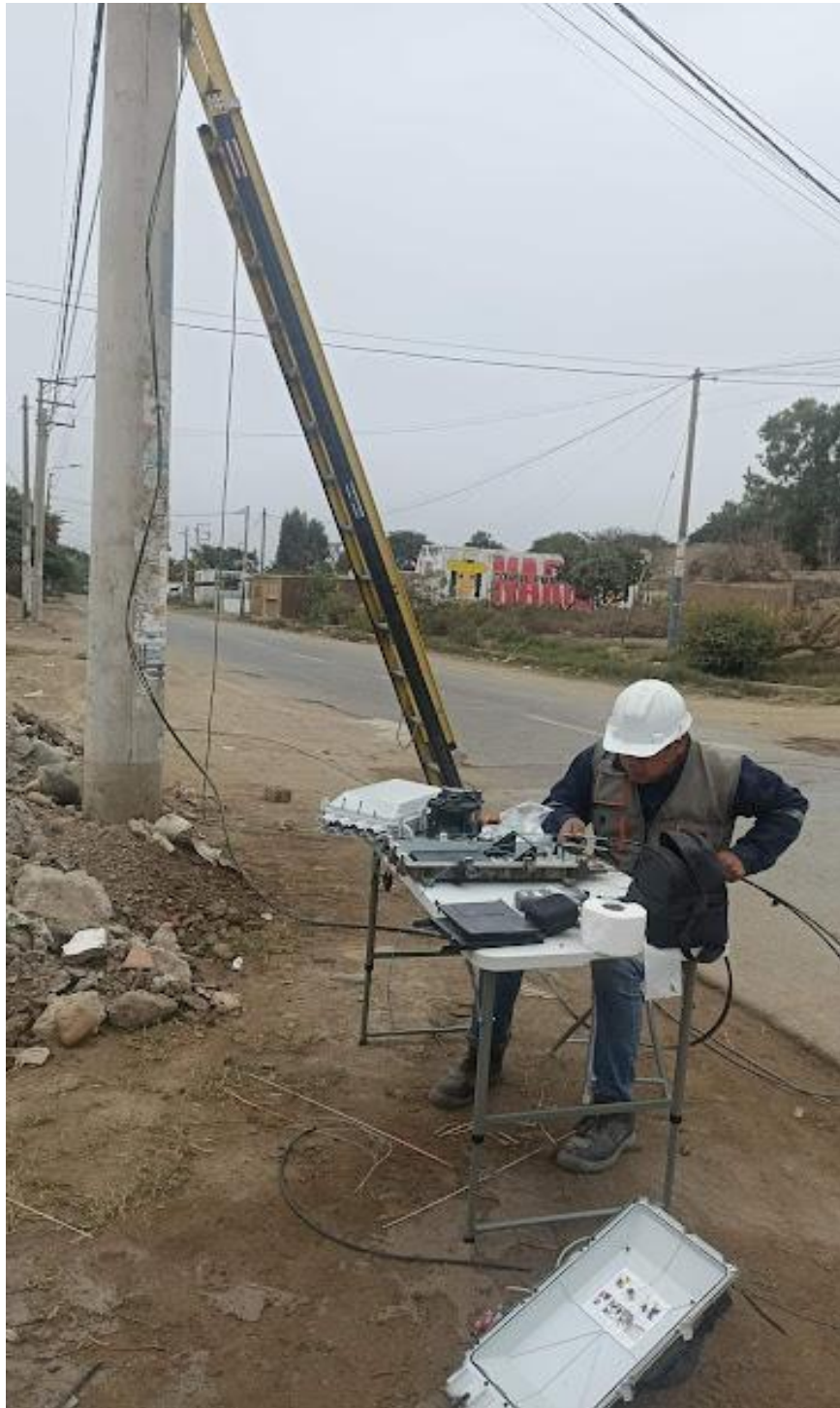
Imagen 2: Acondicionamiento de hilos de fibra Óptica en caja de empalme.
