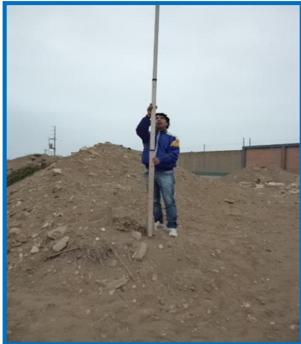
**Fotografía N°04:** Se observa la ubicación de los vértices (BM) del terreno, sobre el cual se realizará la proyección de los ambientes a construir. Asimismo, se observa en el terreno desmonte, el cual será retirado.
