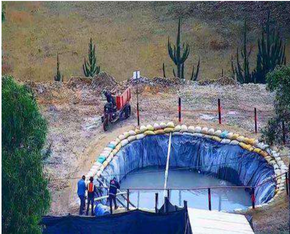
Figura 14 afectación de suelos
