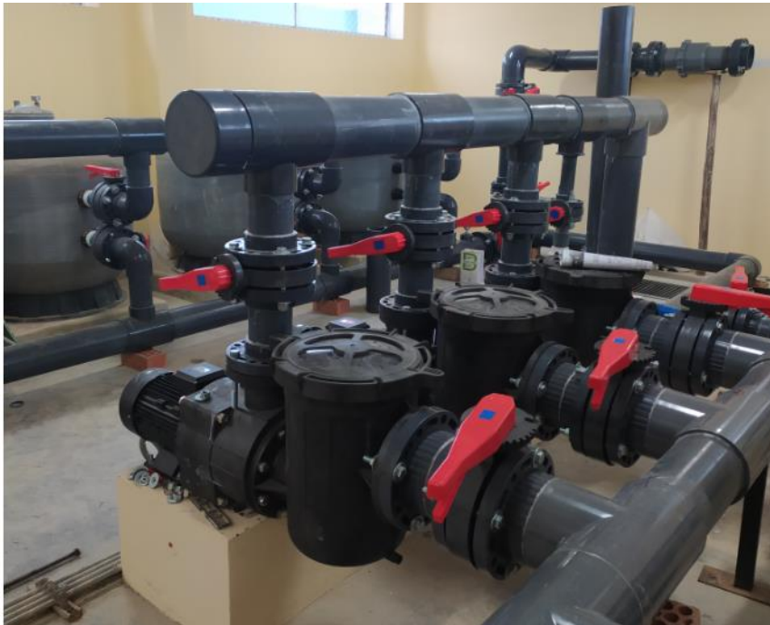
Figura 17. Electrobombas para piscina de polipropileno reforzado.
