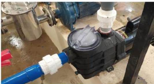
Figura 22. Bomba de aspirado con trampa de pelos.
