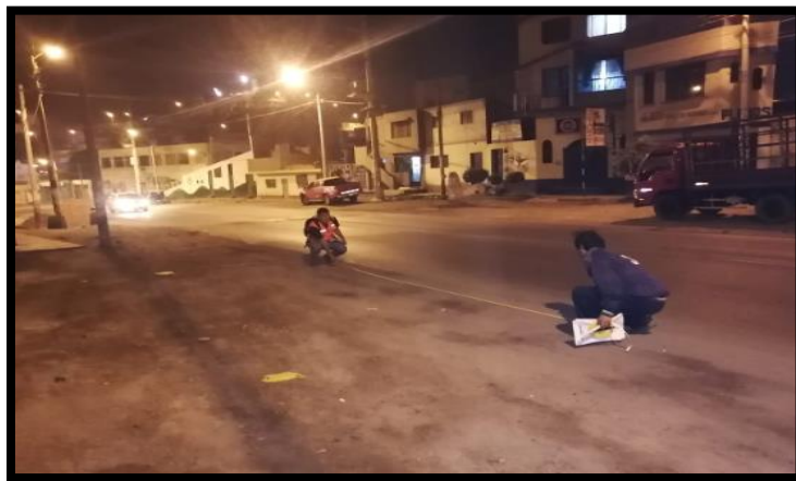
Imagen 21: Medición de las áreas de las fallas
