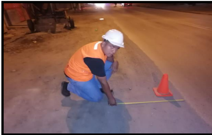
Imagen 4: Medición para la excavación de la C-1
