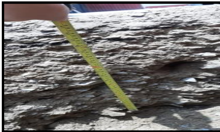
Imagen 12: Espesores de la capa del pavimento flexible
