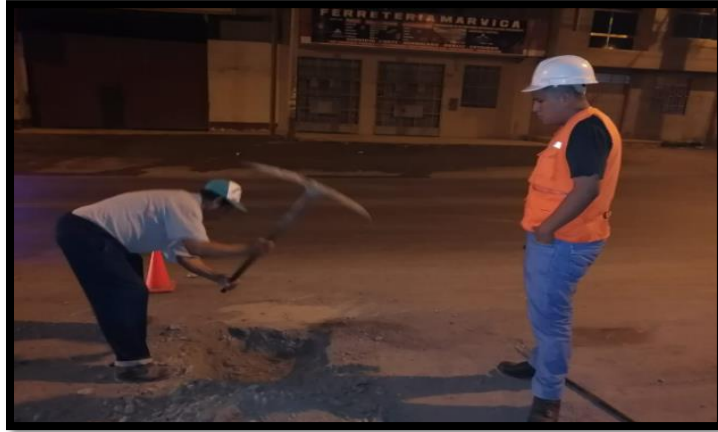
Imagen 5: Excavación de la C-1
