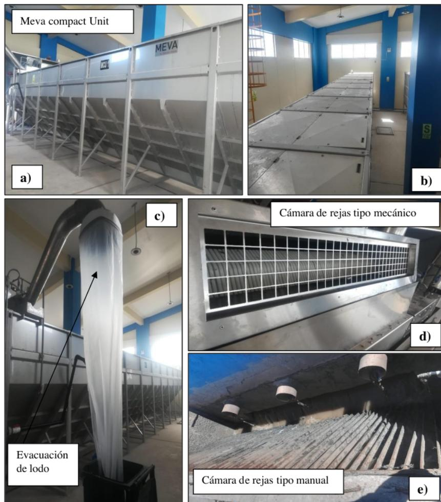
Figura 10. a) MEVA vista perfil; b) MCU vista horizontal; c) evacuación de lodo; d) cámara de rejas mecánico; e) cámara de rejas manual
