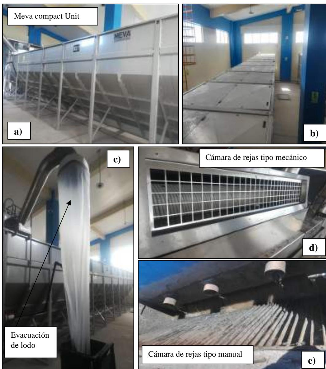
**Figura 10.** a) MEVA vista perfil; b) MCU vista horizontal; c) evacuación de lodo; d) cámara de rejas mecánico; e) cámara de rejas manual
