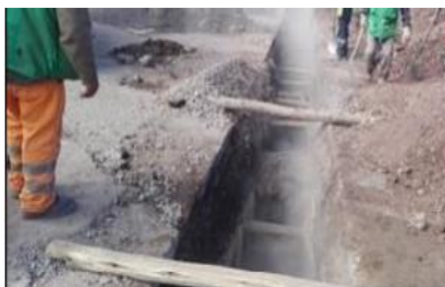
Ilustración 7 Preparación de cama de apoyo para tuberías
