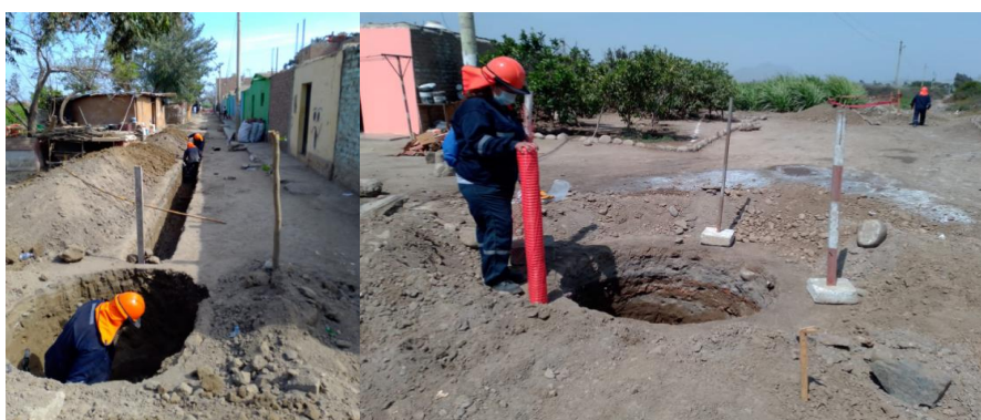
Ilustración 3 Foto 2. Excavación de buzones
