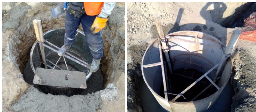
Fuente. Obra de Renovación de Red de Alcantarillado y Conexiones Domiciliarias
