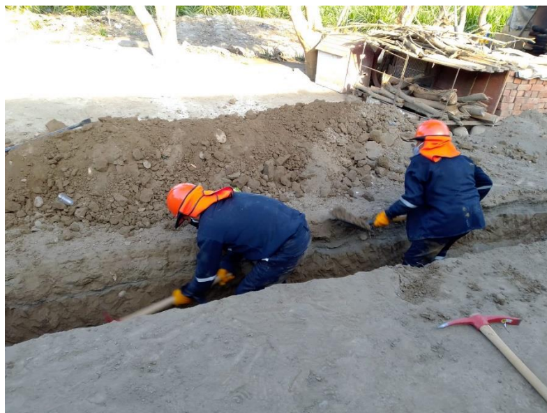
Ilustración 6 Excavación de zanja
