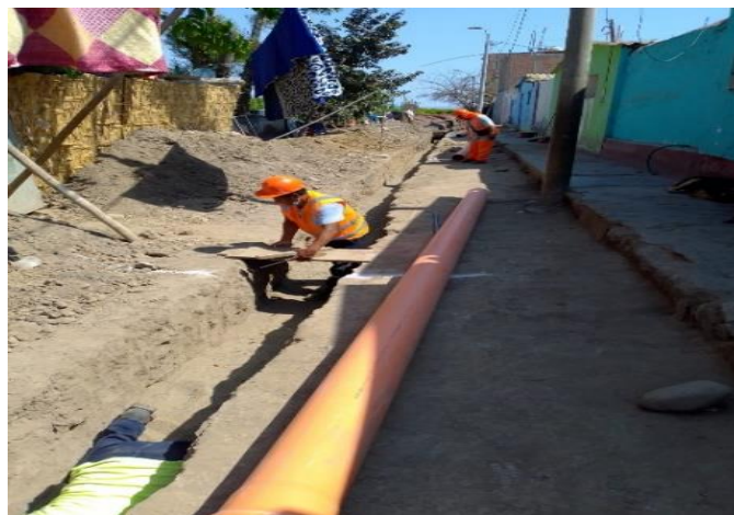
Ilustración 8 Colocación de puntos de nivel y alineación
