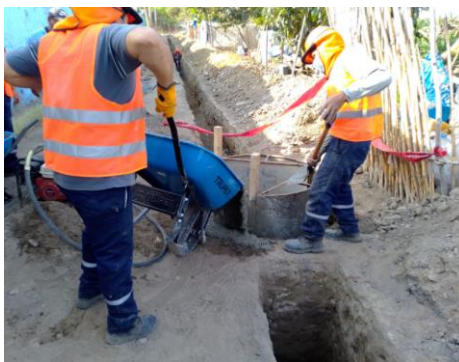
Foto 5. Encofrado de techos de buzones
