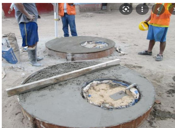
Foto 7. Desencofrado de techos de buzones
