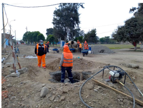
Ilustración 4 Excavación de buzón
