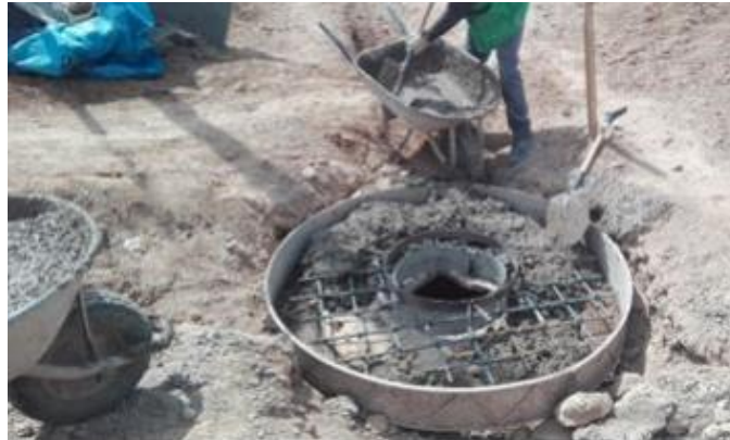
Foto 6. Vaciado de techos de buzones
