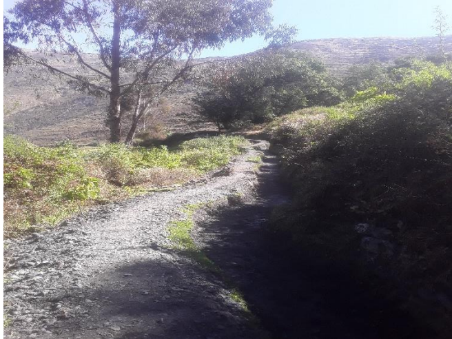
Figura N° 21: Limpieza y/o descolmado de canal natural.
