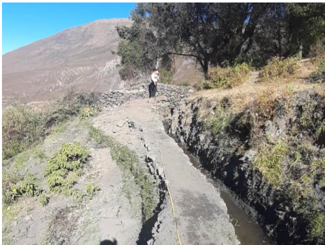
Figura N° 17: Trazo y replanteo de canal natural.
