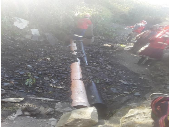
Figura N° 23: Colocación e instalación de tubería.
