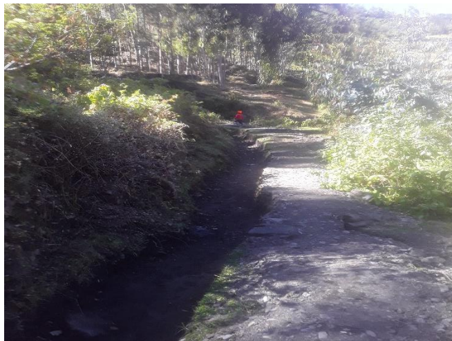
Figura N° 20: Excavación manual de terreno suelto.
