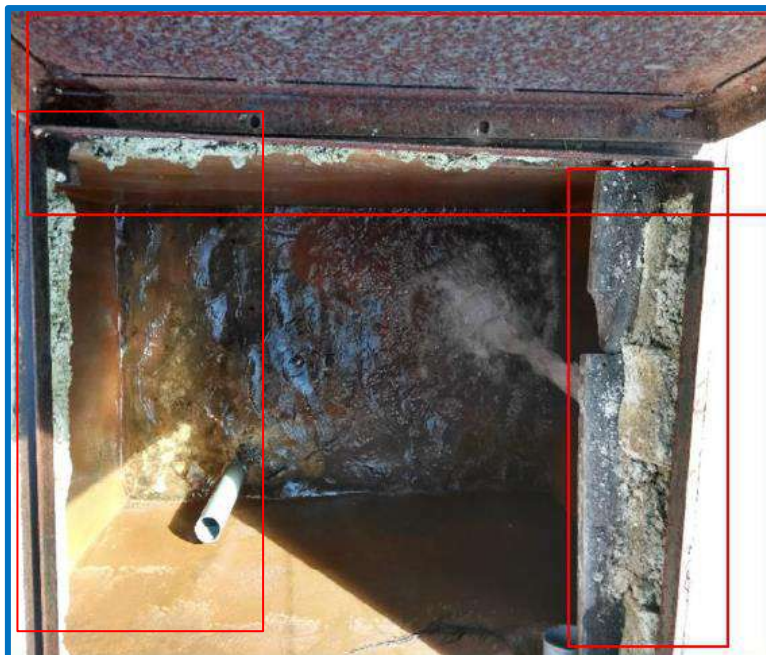
Figura 11: Cámara de captación existente 1
