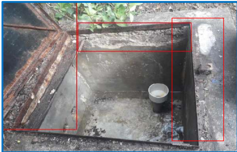
Figura 13: Cámara de captación existente 2
