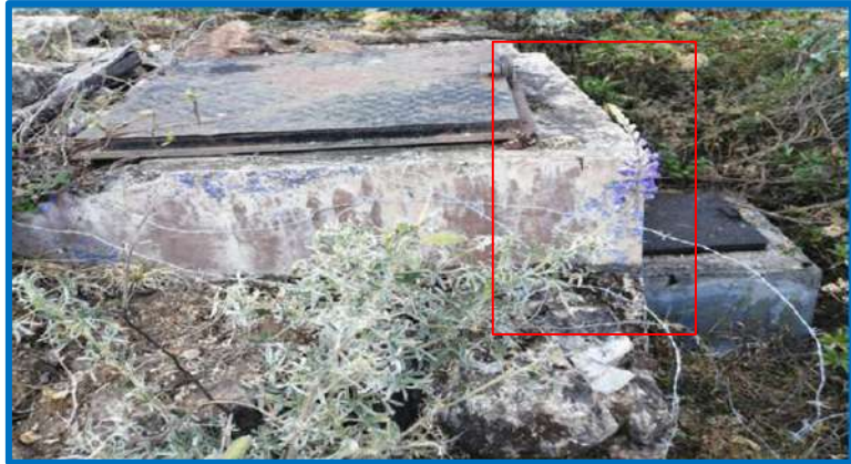
Figura 12: Vista panorámica captación existente 2.
