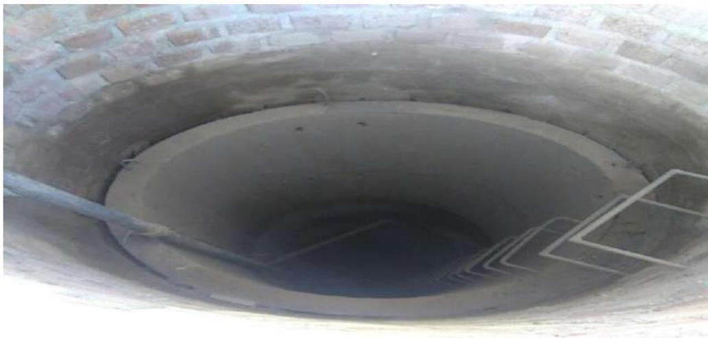
*Vista del interior en desarrollo del Pozo Tubular Existente. Nótese la tubería de succión, escalinata y el fondo con agua estancada y/o arenamiento*
