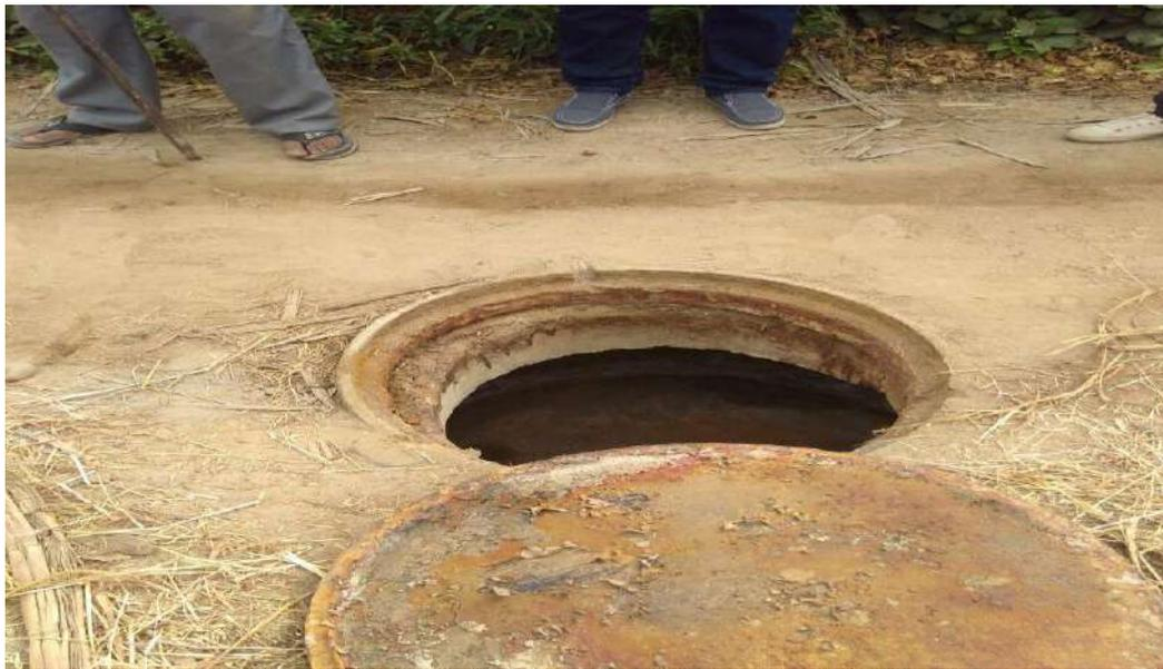
*Vista del Estado actual de interior de los buzones. Se aprecia techo y Tapa de concreto*
