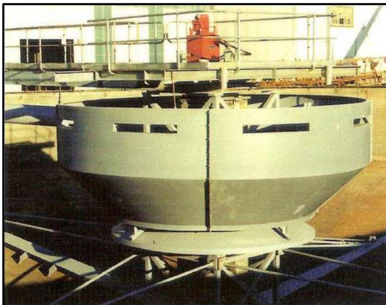
*Ilustración 14. Espesador de alta capacidad - Minera Shauxin.*
