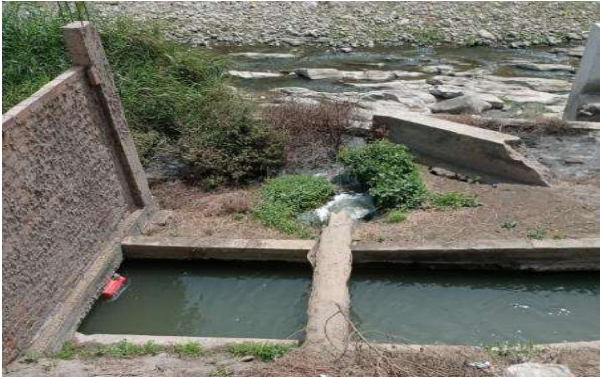
Figura 15. Continuación de la canalización hacia Carquín Chico.
