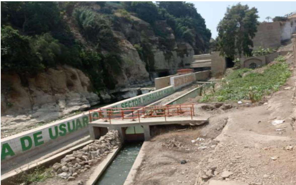
Figura 14. Compuerta de la canalización del canal de riego hacia Carquín Chico.
