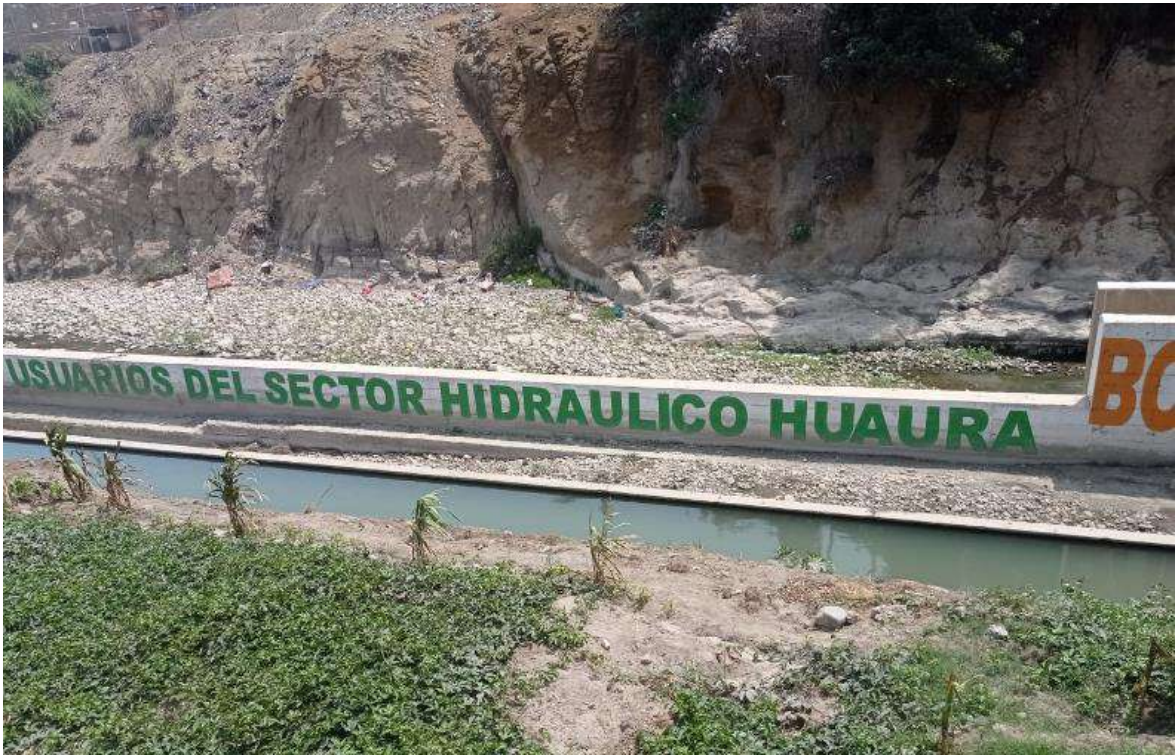
Figura 13. Canalización inicial desde la bocatoma hacia Carquín Chico.
