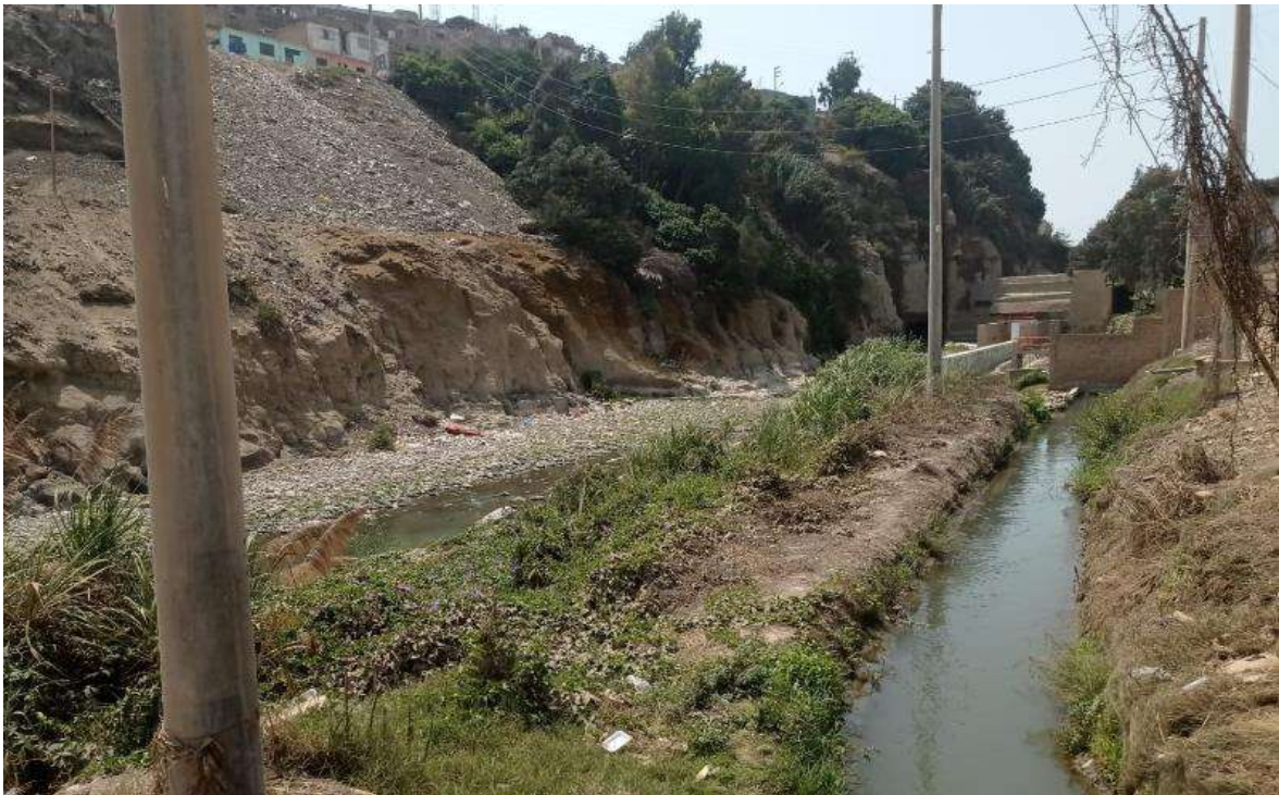
Figura 16. Acequia de regadío hacia Carquín Chico.
