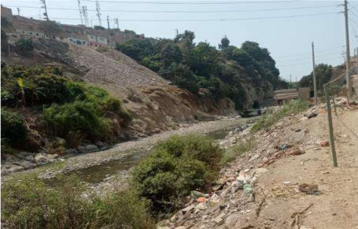
Figura 9. Vista aguas arriba del río Huaura paralela al punto de monitoreo.
