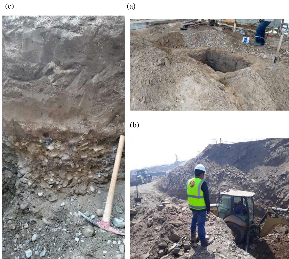
Figura 6: Estudio de Mecánica de Suelos: a) Colegio S.J. Maristas b) Estación de Bombeo N°1 c) Caja Sullana Fuente: INGELCI PERU S.A.C.
