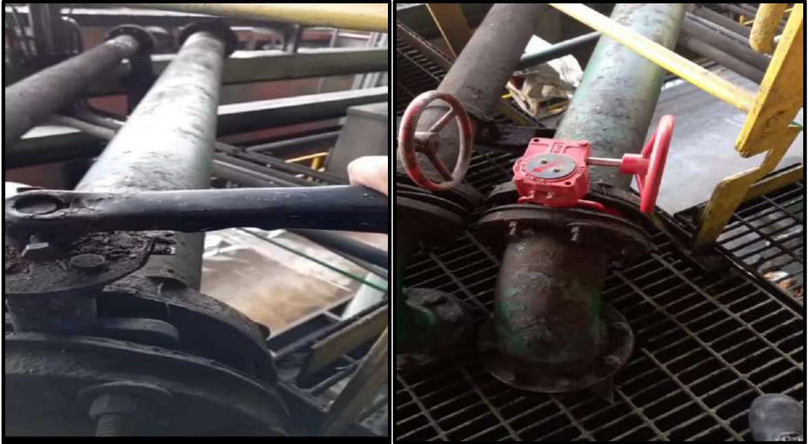
Imagen 1: Cambio de válvula alimentación sello de agua del tanque de preparación TK1
