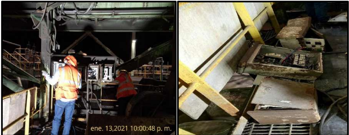
Imagen 2: Cambio de tablero eléctrico y cajas del control de mando del puente grúa.
