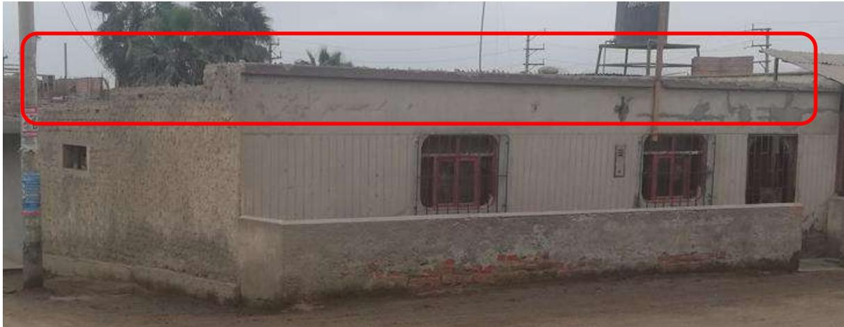
Por lo que de acuerdo a las bases teóricas el parámetro para en este criterio es el “C”, ya que el diafragma observado no cumple con la losa de concreto rígido o estructuras metálicas y la conexión del diafragma al muro no es eficaz ya que no se transmiten de esa forma las cargas distribuidas de la losa de adobe.
