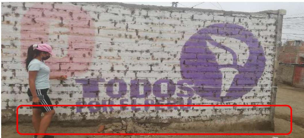
De lo cual observamos inexistencia de vigas de cimentación, a pesar de la inclinación que tiene ya que en la figura 21 podemos notas la inclinación en falda de cerro entre un 0,03 (30%) pero sin ningún tipo de existencia de terraplén, solo viviendas colindantes con características similares. **Por lo que de acuerdo a las bases teóricas el parámetro para en este criterio es el “C”, el cual indica que no presenta vigas de cimentación, el desnivel a partir del 30%.**
