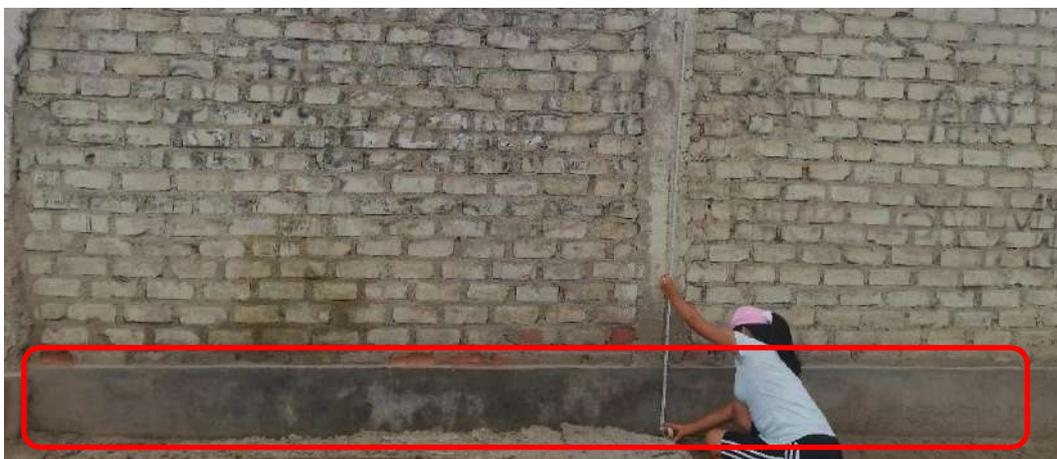
De lo cual observamos inexistencia de vigas de cimentación, no hay presencia de inclinación como se muestra en la figura 41, sin ningún tipo de existencia de terraplén, solo viviendas colindantes con características similares. **Por lo que de acuerdo a las bases teóricas el parámetro para en este criterio es el “A”, el cual presenta vigas corridas y con una pendiente menor al 10 por ciento.**
