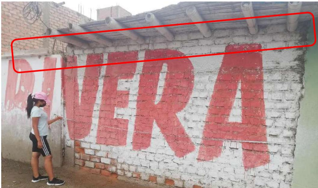
**Por lo que de acuerdo a las bases teóricas el parámetro para en este criterio es el “C”, ya que el diafragma observado no cumple con la losa de concreto rígido o estructuras metálicas y la conexión del diafragma al muro no es eficaz ya que no se transmiten de esa forma las cargas distribuidas de la losa de adobe.**
