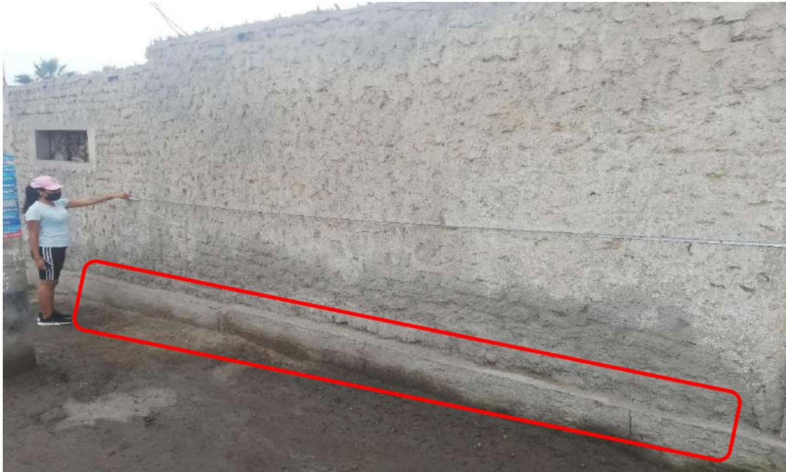
De lo cual observamos inexistencia de vigas de cimentación, a pesar de la inclinación que tiene ya que en la figura 13 podemos notas la inclinación en falda de cerro entre un 0,03 (30%) pero sin ningún tipo de existencia de terraplén, solo viviendas colindantes con características similares. **Por lo que de acuerdo a las bases teóricas el parámetro para en este criterio es el “C”, el cual indica que no presenta vigas de cimentación, el desnivel a partir del 30%.**
