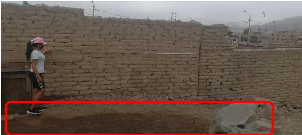
De lo cual observamos inexistencia de vigas de cimentación, a pesar de la inclinación que tiene ya que en la figura 53 podemos notas la inclinación en falda de cerro entre un 0,03 (30%) pero sin ningún tipo de existencia de terraplén, solo viviendas colindantes con características similares. **Por lo que de acuerdo a las bases teóricas el parámetro para en este criterio es el “C”, el cual indica que no presenta vigas de cimentación, el desnivel a partir del 30%.**
