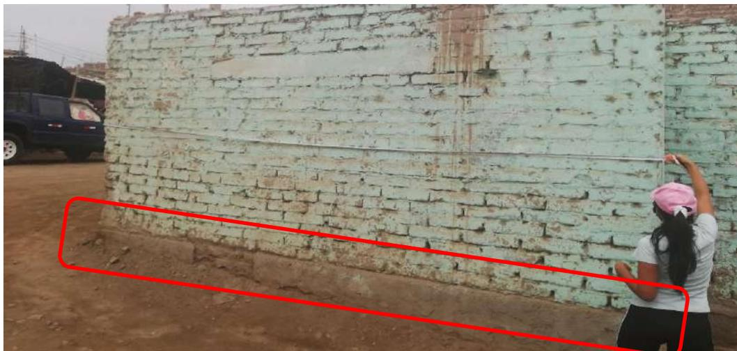
De lo cual observamos inexistencia de vigas de cimentación, a pesar de la inclinación que tiene ya que en la figura 35 podemos notas la inclinación en falda de cerro entre un 0,015 (15%) pero sin ningún tipo de existencia de terraplén, solo viviendas colindantes con características similares. **Por lo que de acuerdo a las bases teóricas el parámetro para en este criterio es el “C”, el cual indica que no presenta vigas de cimentación, el desnivel a partir del 20%.**
