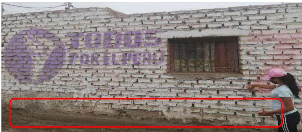
De lo cual observamos inexistencia de vigas de cimentación, a pesar de la inclinación que tiene ya que en la figura 28 podemos notas la inclinación en falda de cerro entre un 0,02 (20%) pero sin ningún tipo de existencia de terraplén, solo viviendas colindantes con características similares. **Por lo que de acuerdo a las bases teóricas el parámetro para en este criterio es el “C”, el cual indica que no presenta vigas de cimentación, el desnivel a partir del 20%.**
