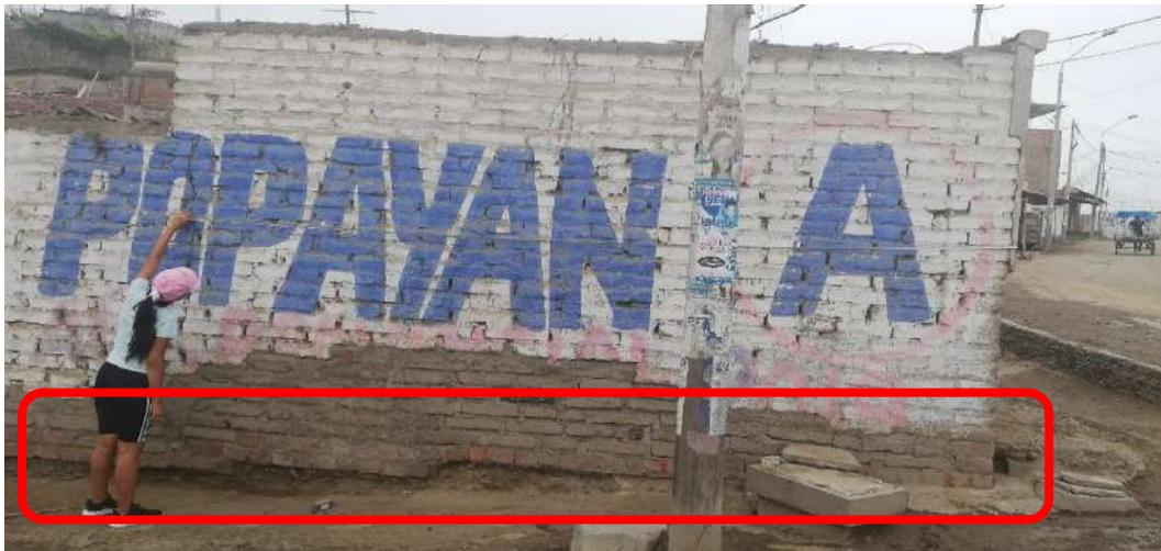
De lo cual observamos inexistencia de vigas de cimentación, a pesar de la inclinación que tiene ya que en la figura 47 podemos notas la inclinación en falda de cerro entre un 0,03 (30%) pero sin ningún tipo de existencia de terraplén, solo viviendas colindantes con características similares. **Por lo que de acuerdo a las bases teóricas el parámetro para en este criterio es el “C”, el cual indica que no presenta vigas de cimentación, el desnivel a partir del 30%.**
