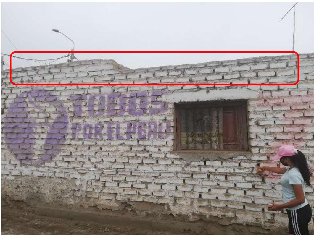
Por lo que de acuerdo a las bases teóricas el parámetro para en este criterio es el “C”, ya que el diafragma observado no cumple con la losa de concreto rígido o estructuras metálicas y la conexión del diafragma al muro no es eficaz ya que no se transmiten de esa forma las cargas distribuidas de la losa de adobe.
