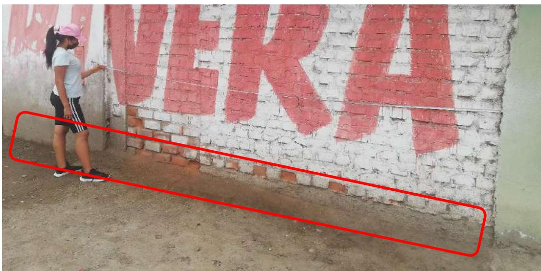
De lo cual observamos inexistencia de vigas de cimentación, no hay presencia de inclinación como se muestra en la figura 59, sin ningún tipo de existencia de terraplén, solo viviendas colindantes con características similares. **Por lo que de acuerdo a las bases teóricas el parámetro para en este criterio es el “A”, el cual presenta vigas corridas y con una pendiente menor al 10 por ciento.**
