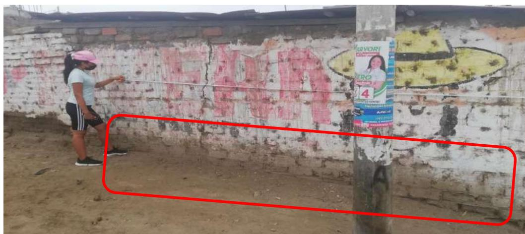
De lo cual observamos inexistencia de vigas de cimentación, a pesar de la inclinación que tiene ya que en la figura 6 podemos notas la inclinación en falda de cerro entre un 0,03 (30%) pero sin ningún tipo de existencia de terraplén, solo viviendas colindantes con características similares. **Por lo que de acuerdo a las bases teóricas el parámetro para en este criterio es el “C”, el cual indica que no presenta vigas de cimentación, el desnivel a partir del 30%.**
