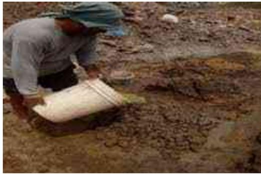
Fig 15. Colocación del agua mezclada con el estabilizante
