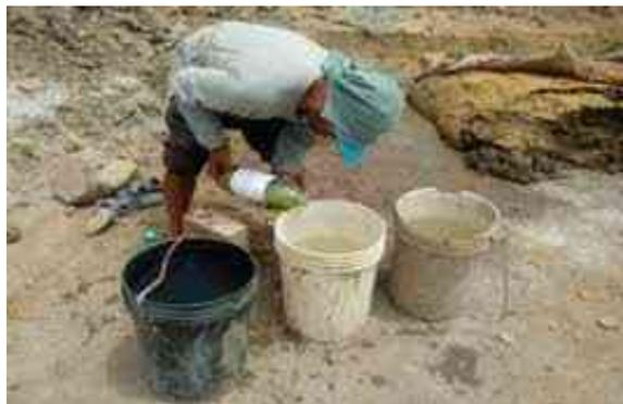
Fig 14. Mesclado del agua para la elaboración de las unidades de adobe
