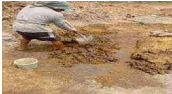
Fig 13. Remojo de la tierra para ser mezclada con agua estabilizada
