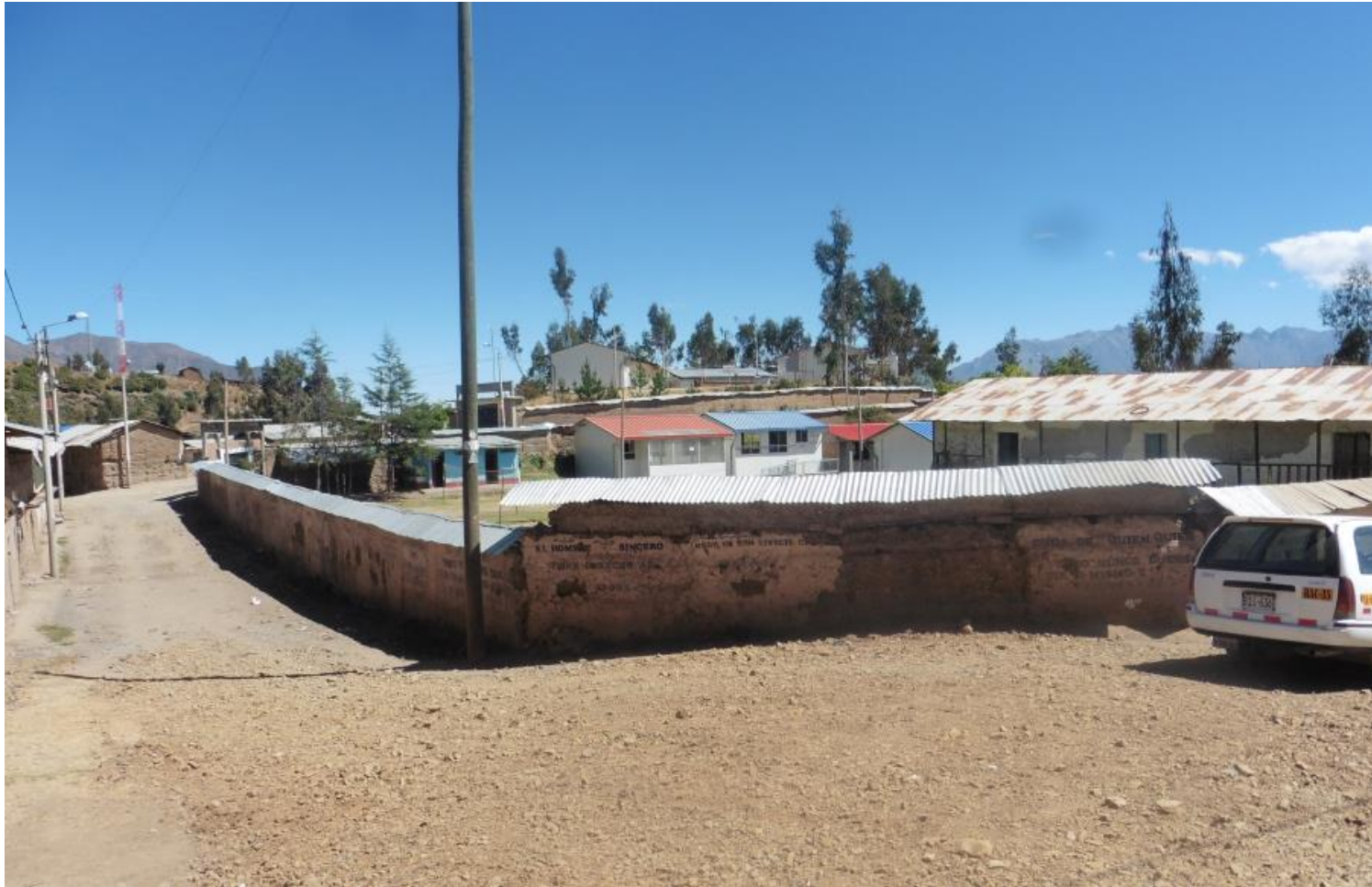
Fotografía 3 Vista panorámica de la infraestructura del colegio Actual
