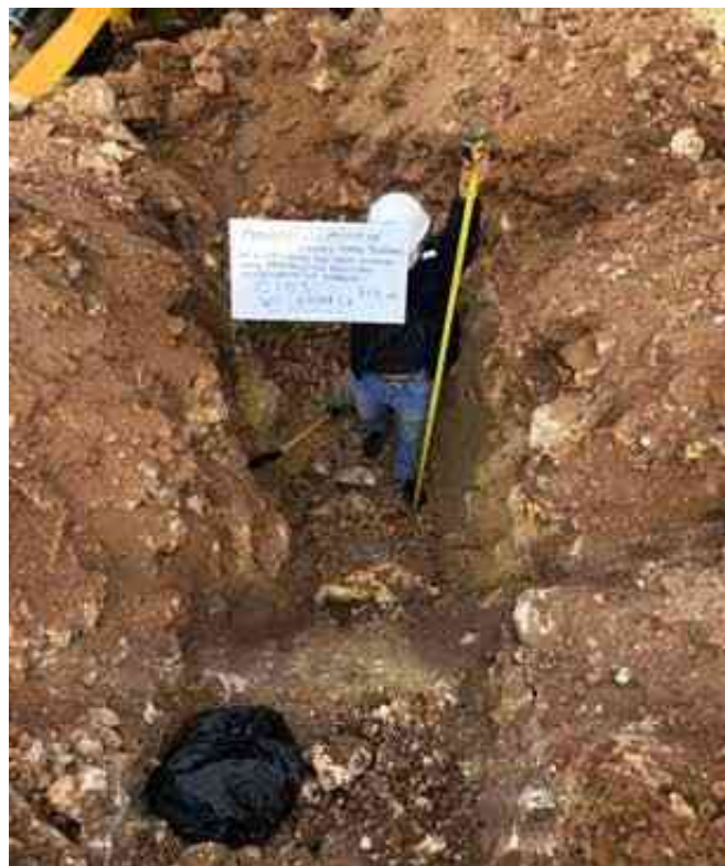
Calicata No.03 Celda de Residuos
