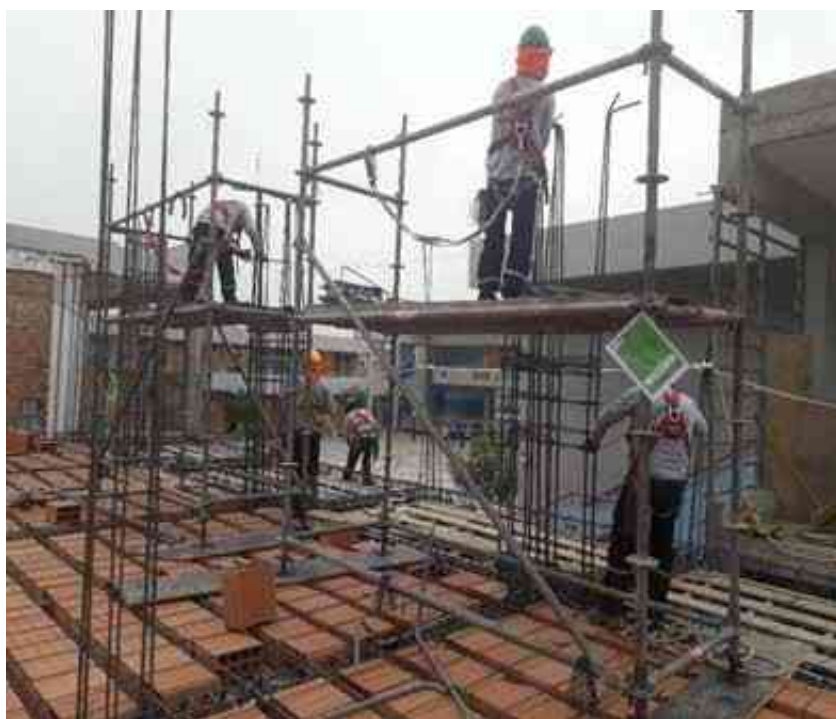
Figura 12. Armado de Columnas en el segundo nivel del Pabellón “B”. Trabajo en altura en Consorcio Amazonas S.A.C. – Barranca.
