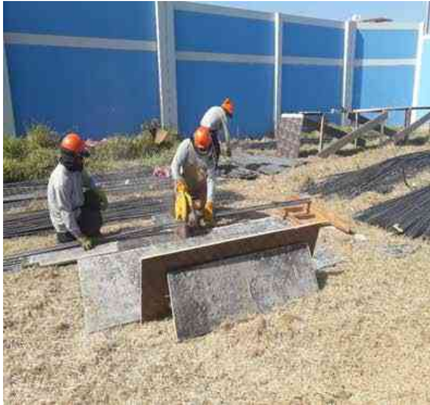
Figura 13. Cortado de fierros con la tronzadora. Trabajo en caliente: uso correcto de Equipos de Protección Personal y biombos en la empresa Consorcio Amazonas S.A.C. – Barranca.
