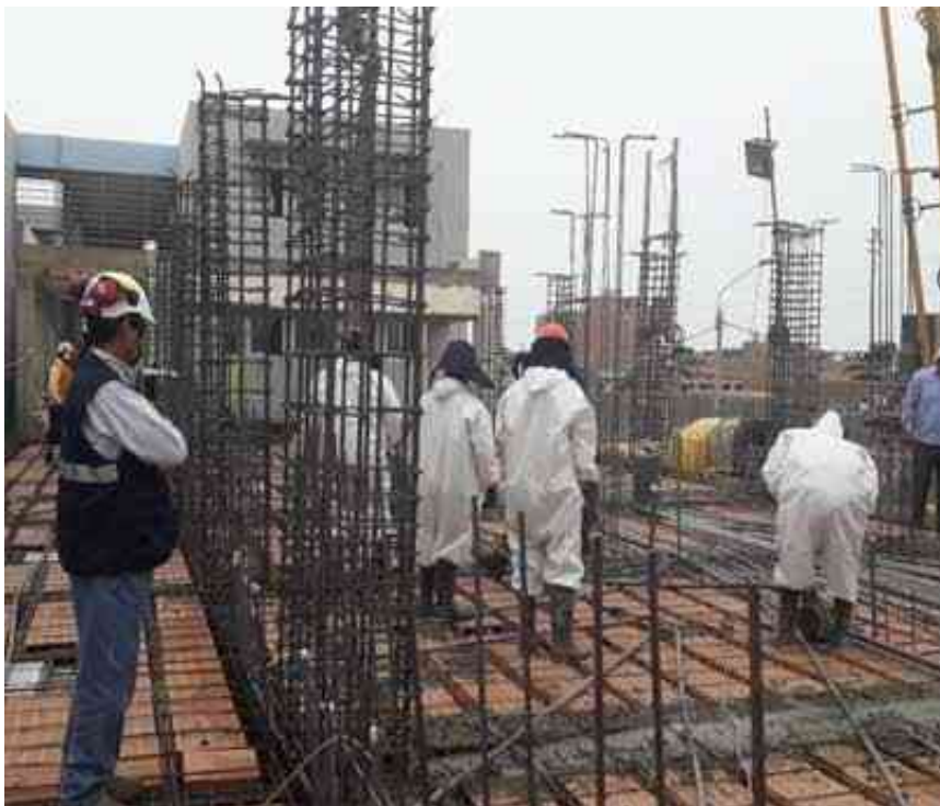
Figura 13. Cortado de fierros con la tronzadora. Trabajo en caliente: uso correcto de Equipos de Protección Personal y biombos en la empresa Consorcio Amazonas S.A.C. – Barranca.
