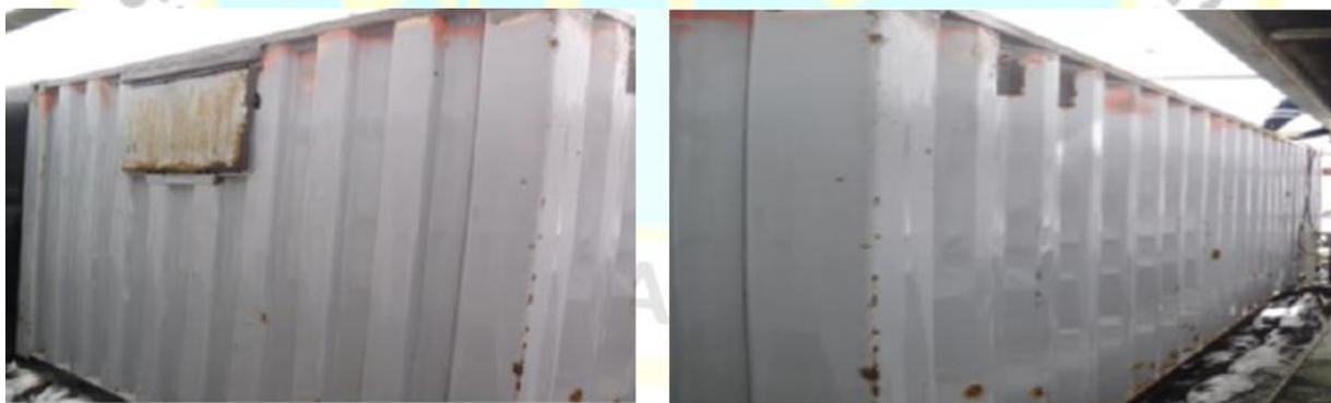
Figura 19. Contenedores antes de la preparación de superficie
