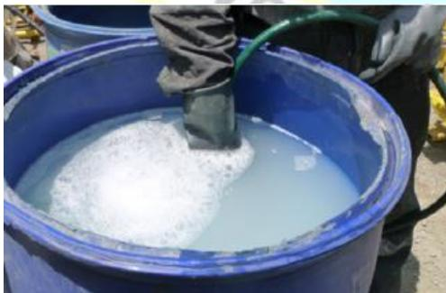
*Figura 6.* Preparación de la solución de detergente para limpieza de superficie.
