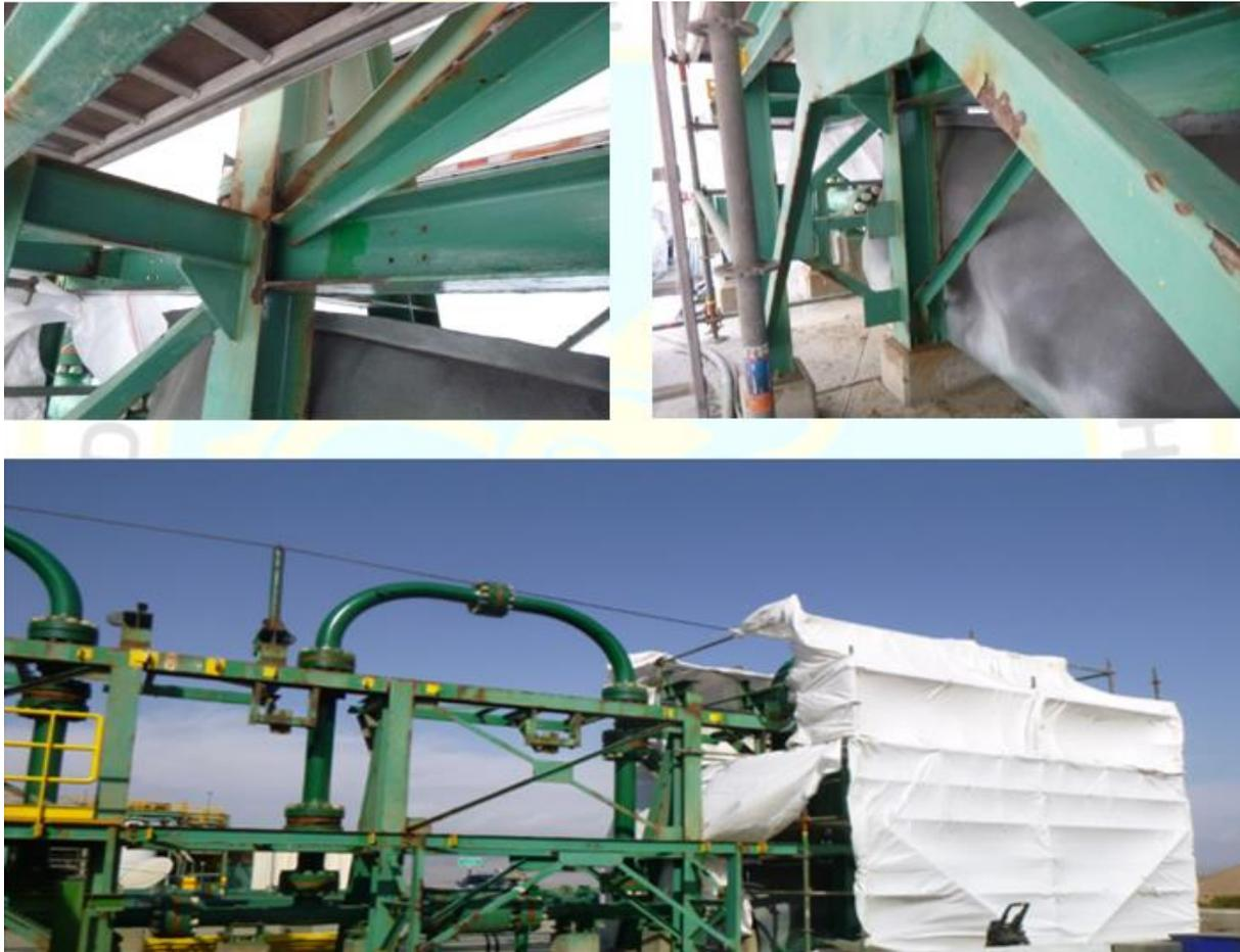
*Figura 11.* Presencia de óxido durante el lavado de estructuras
