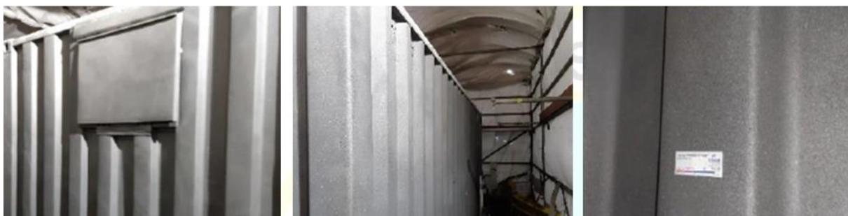
*Figura 20.* Superficie preparada de los contenedores después del escoriado
