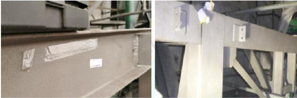
Figura 22. Superficie preparada de estructuras después del escoriado
