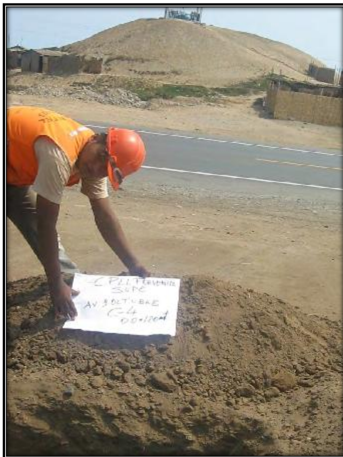
FOTO N° 17: CALICATA N° 4 PARA TOMA DE MUESTRAS (ESTUDIO DE SUELOS)
