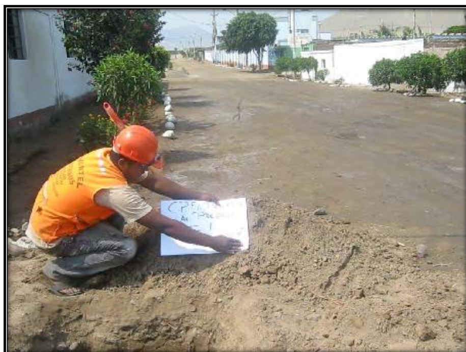
FOTO N° 16: VISTA DE LA AV. PROGRESO DONDE SE TOMO MUESTRAS DE SUELOS
