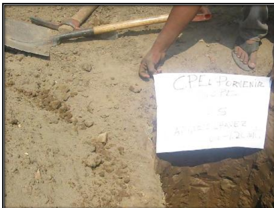
FOTO N° 18: EXCAVACION DE LA CALICATA N° 5
