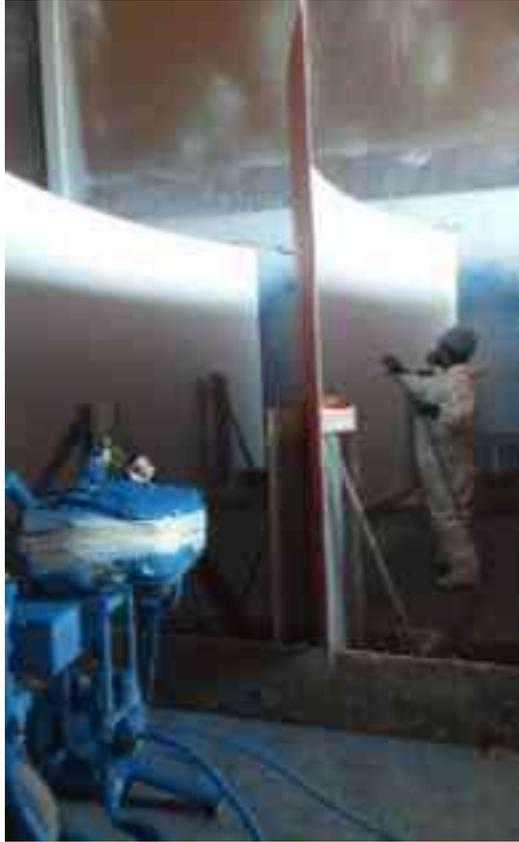
Figura 25. Aplicación del Macropoxy 646 en las planchas de muestra.
