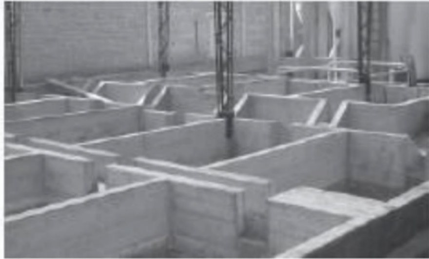
Fig. 10. Espesamiento y secado de lodos mediante lechos de secado
