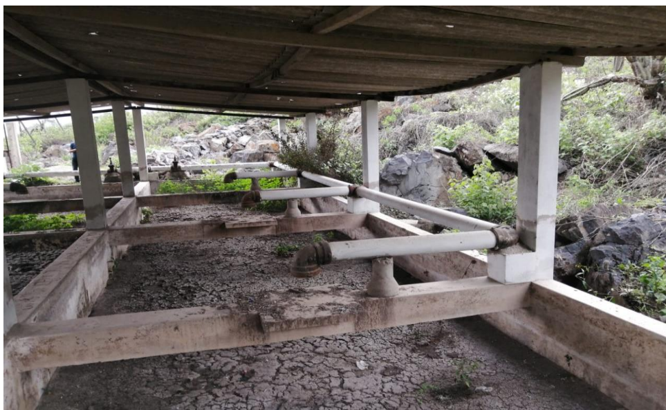
Figura 46. Vista del Interior de Lecho de Secado Existente de la PTAR, inoperativo.
