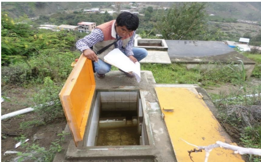
Figura 21. Vista del interior del Reservorio de Agua Potable en Ambar.
