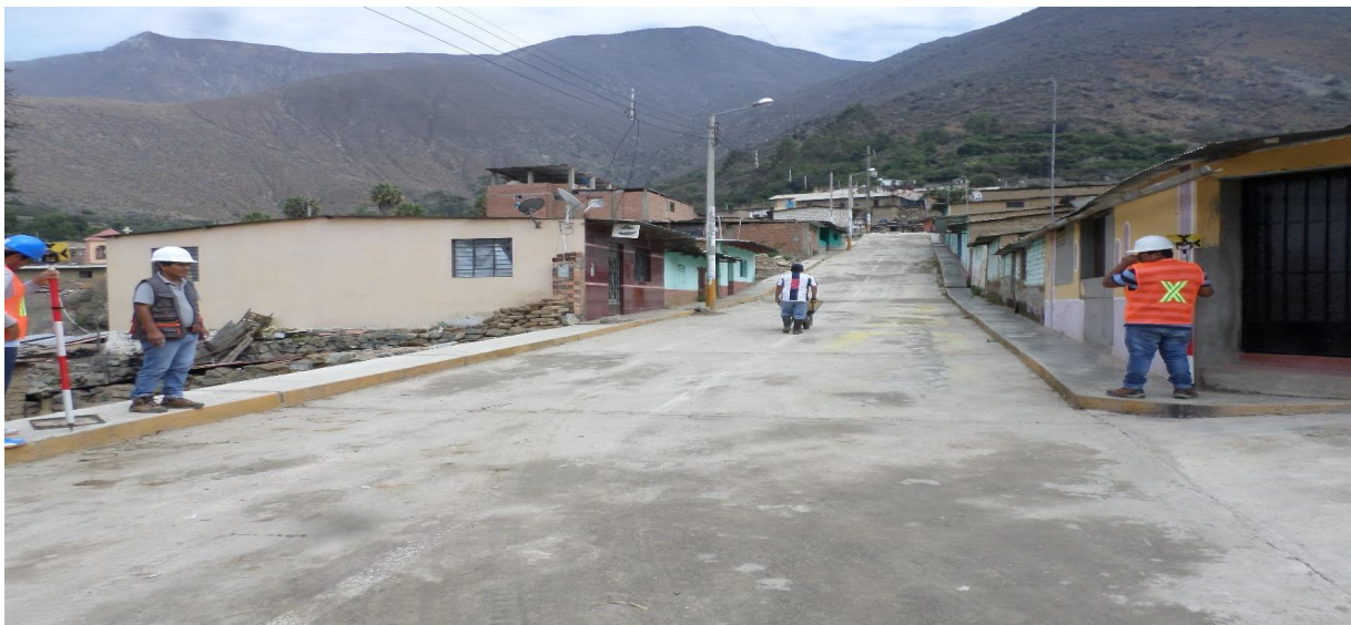
Figura 28. Vista de la calle Jirón de Agosto la cual como se puede ver es de pavimento rígido con veredas en este sector no cuenta con cunetas por tanto solo aprovecha la pendiente de la calle y descarga las aguas residuales a un descampado en terrenos de cultivo.
