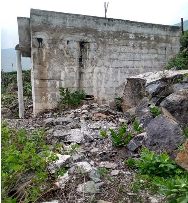
Figura 39. Vista de las Paredes Laterales de H=10 m. del Tanque Imhoff Existente.
