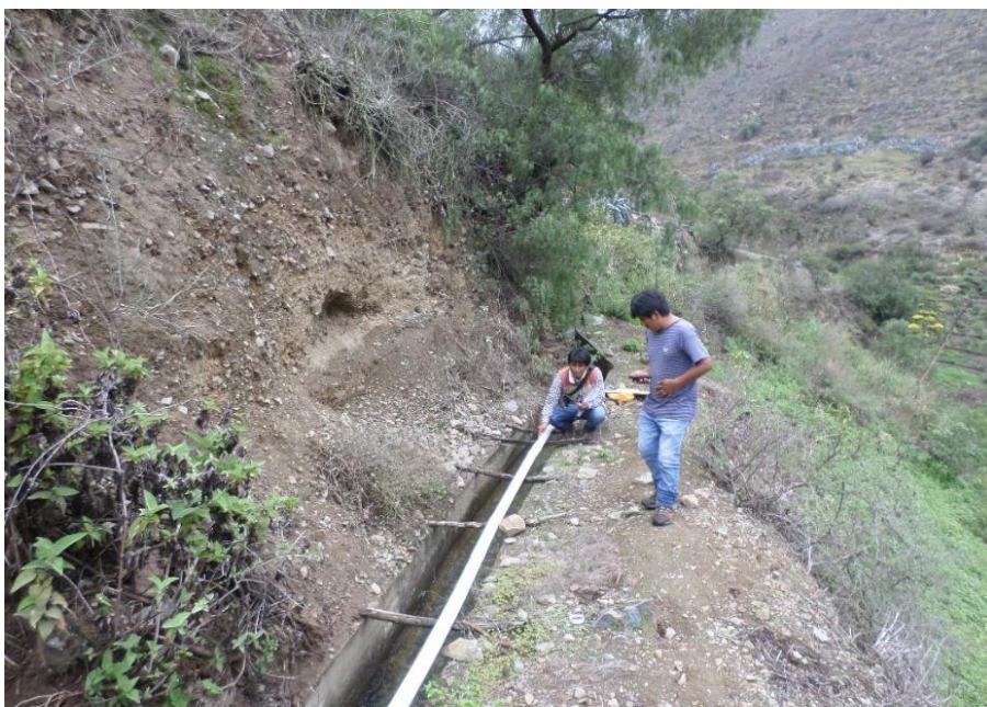
Figura 20. Vista de la Evaluación del estado de la Línea de Conducción la cual se encuentra expuesta.
