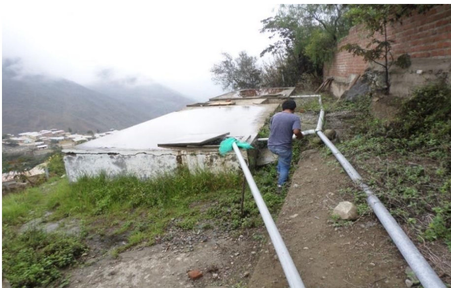
Figura 22. Vista del Exterior del Reservorio de Agua Potable existente en la Localidad de Ambar.
