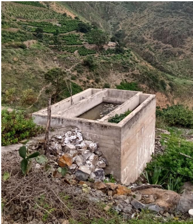
Figura 38. Vista Panorámica del Estado actual de la Infraestructura del Tanque Imhoff.
