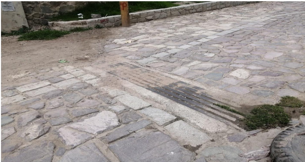
Figura 26. Canaleta se ubica en la calle Alfonso Ugarte, estas son descargadas en una quebrada Ulunte ubicada en la entrada que luego termina al río Ámbar.
