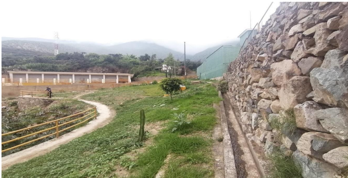
Figura 27. Vista del cauce de la quebrada donde termina todas aguas provenientes de las lluvias, por su nivel de cota es aquí donde se descargan los drenajes pluviales.
