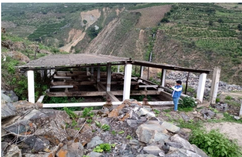
Figura 44. Vista del Exterior de Lecho de Secado Existente de la PTAR, inoperativo. Fuente: Elaboración propia.
