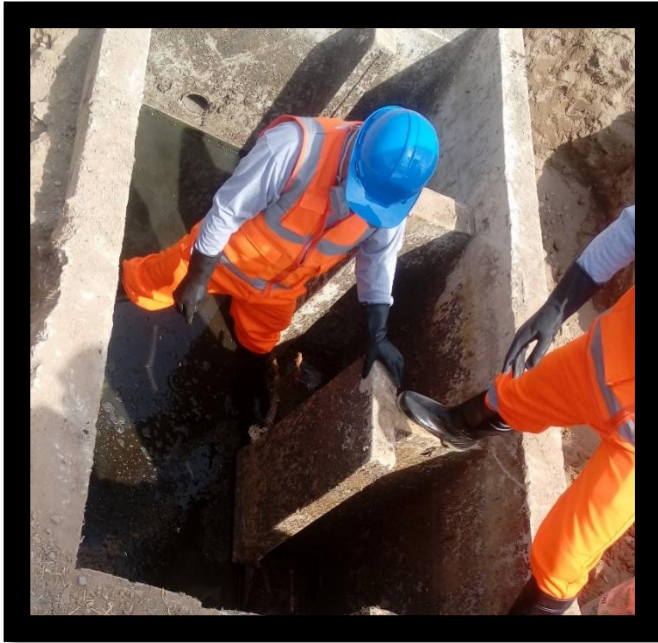
Figura N°21: Aguas residuales en cámara de caudales
