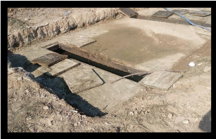
Figura N°18: Apertura del desarenador
