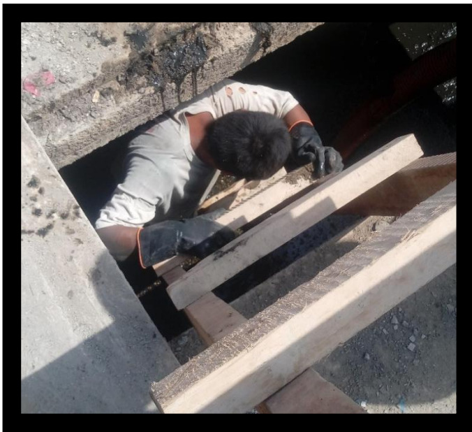
Figura N°22: Calculando cantidad de lodo en desarenador
