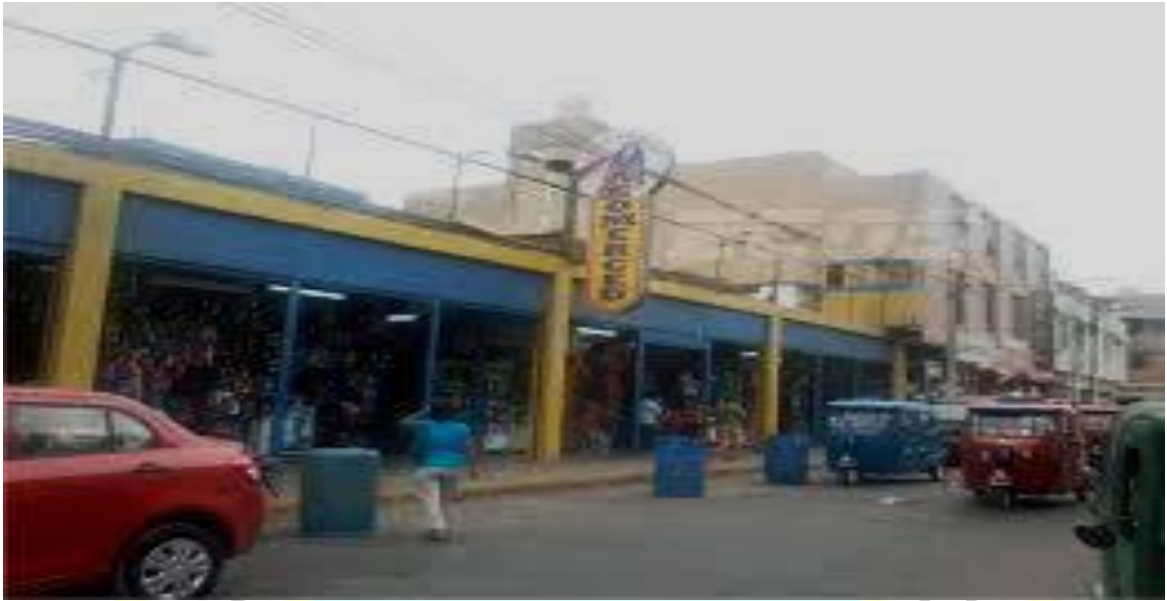
Figura 6. Centro comercial con depósitos en la parte exterior.
