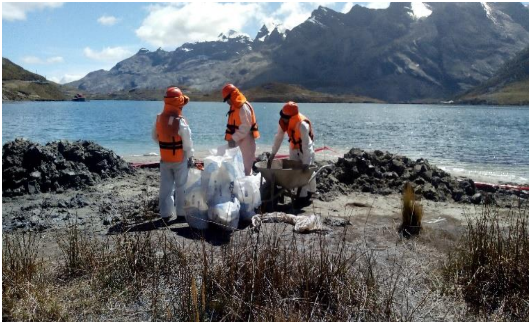
figura 14: Acondicionamiento material de relave
