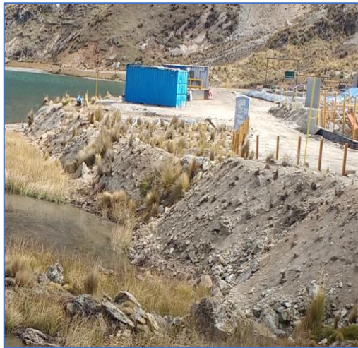
Figura 9 b. Zona transitoria de acopio de relaves Fuente: galería fotográfica de la empresa
