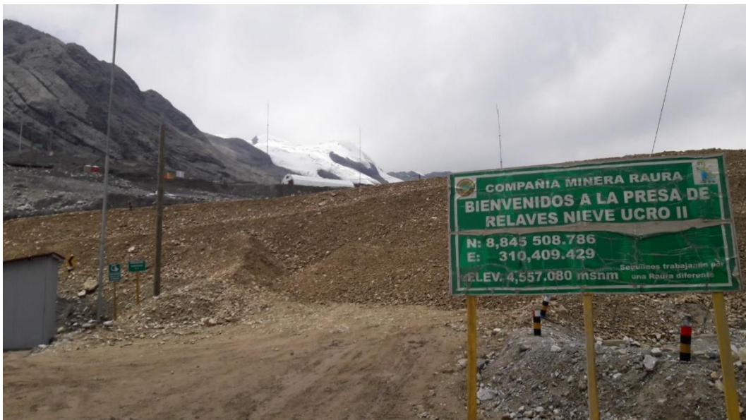
Figura 10b. Presa de disposición de relaves Nieve Ucro II Fuente: galería fotográfica de la empresa
