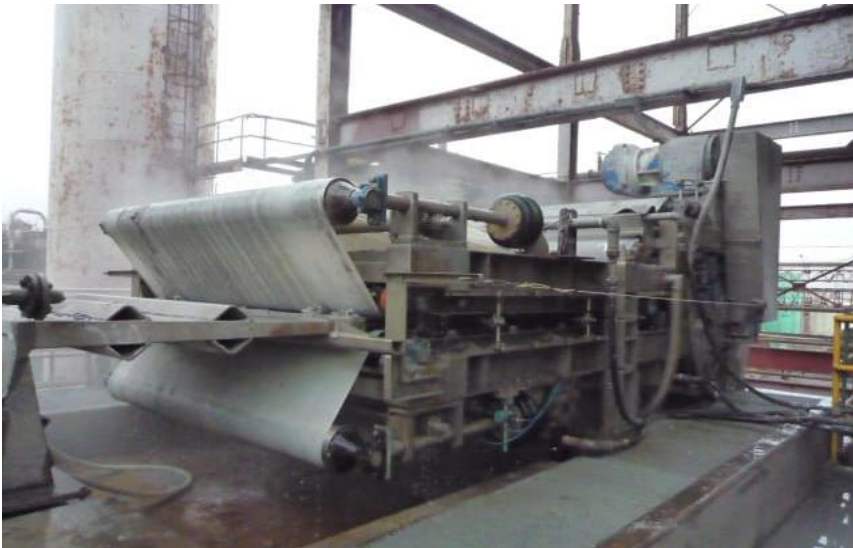
Figura 21. Filtro prensa para tratamiento de lodos.
