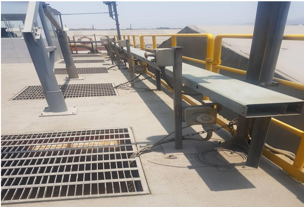
Figura 34. Zona superior de bombas sumergibles de mezclas.
