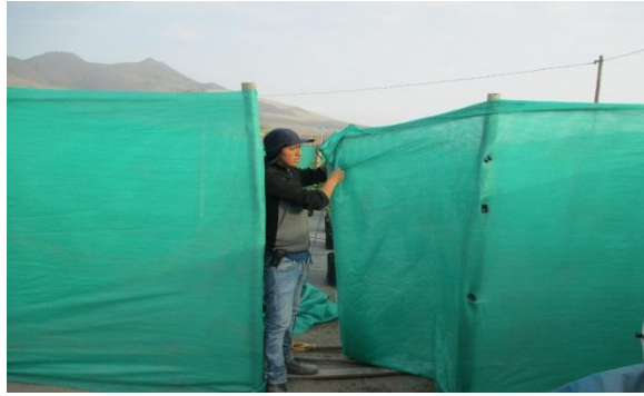
Figura 21. Construcción de casa malla
