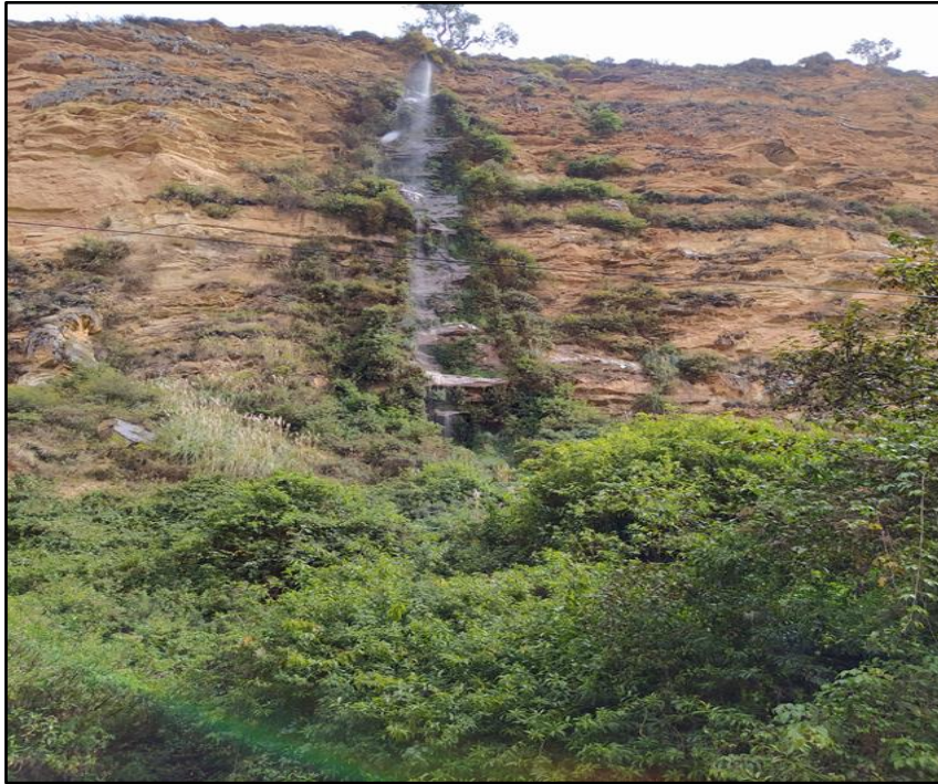
Figura 17. Vertimiento de aguas residuales al río Aco
