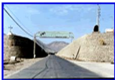
Ingreso a Andahuasi
