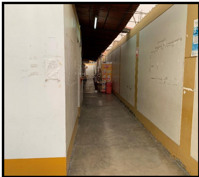
Ilustración 10 Sección interior del puesto de salud Domingo Mandamiento
