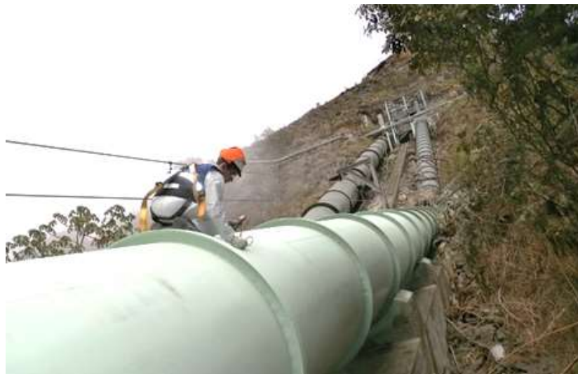
Figura 23 Medición de espesor de pintura seca según SSPC – PA2
