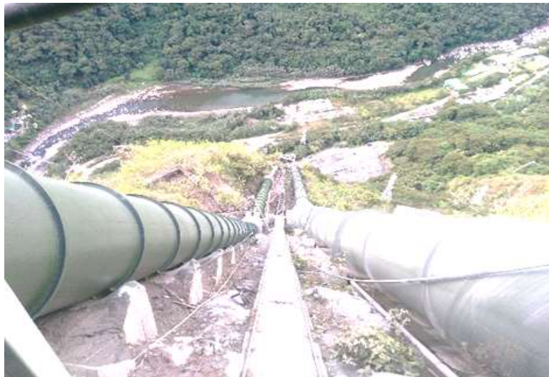
Figura 21 Aplicación de recubrimiento poliuretano alifático.
