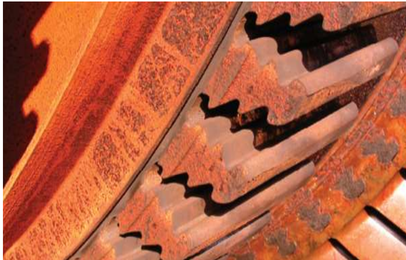
Figura 8 Corrosión por fatiga.
