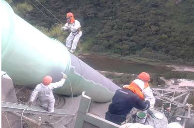
Figura 19 Aplicación de recubrimiento epoxi.
