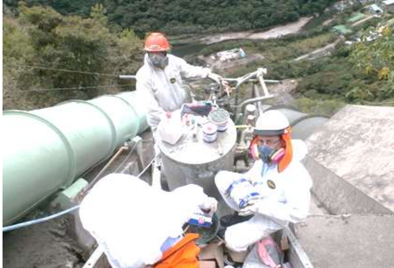
Figura 20 Aplicación de recubrimiento poliuretano alifático.
