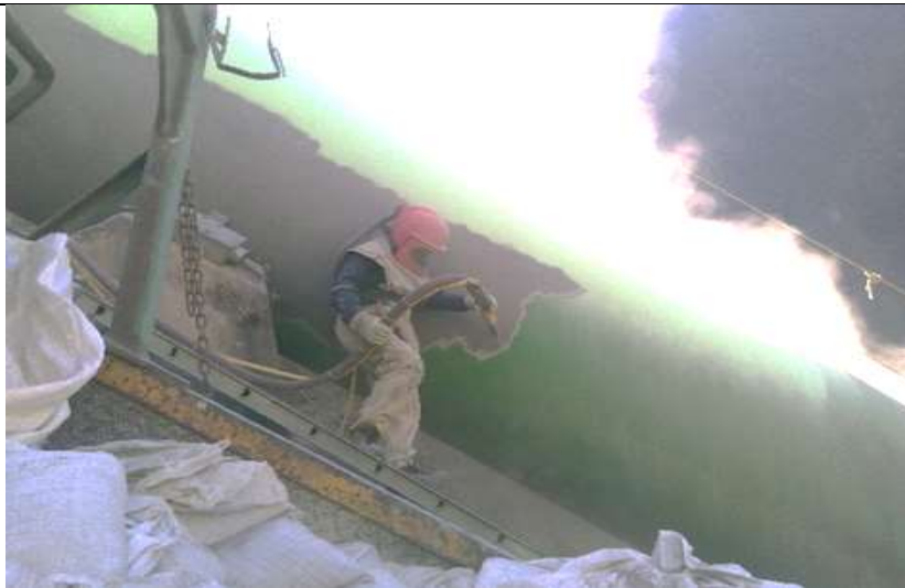
Figura 17 Limpieza con chorro abrasivo de las virolas.
