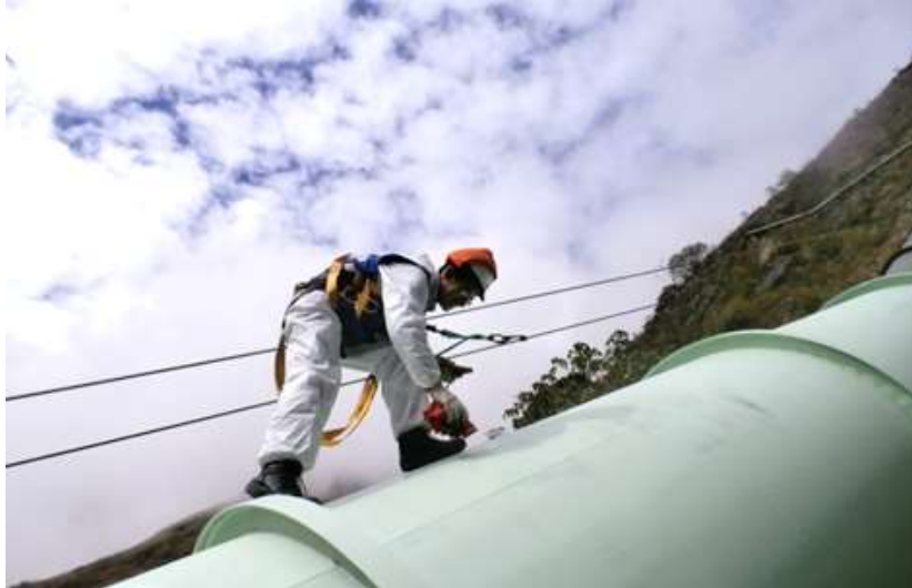
Figura 22 Medición de espesor de pintura seca de ULTRAMASTIC 850 HSHB - RAL 6019
