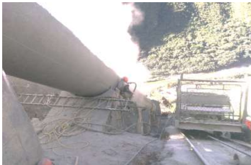
Figura 18 Limpieza con chorro abrasivo según SSPC-SP6.
