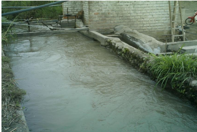
Figura 5. Línea de Conducción
