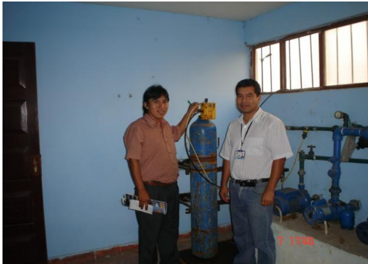
Figura 14. Tesistas en el área de dosificación de cloro
